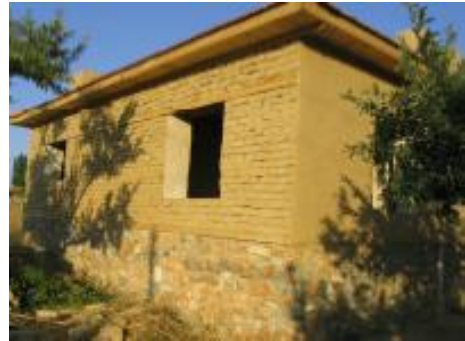
Şekil 2.4. Hatıllı kerpiç bir yapı(Korkmaz, 2007).
