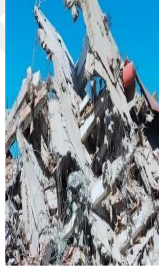
Şekil 2.10. Kusurlu beton kaynaklı hasar, Adıyaman (AFAD, 2023).
