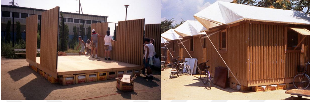
Şekil 3.15. 1999 Kobe depremi sonrası geçici barınma birimlerinin inşaat aşaması ve toplu konut olarak kullanımı (Url 11).
