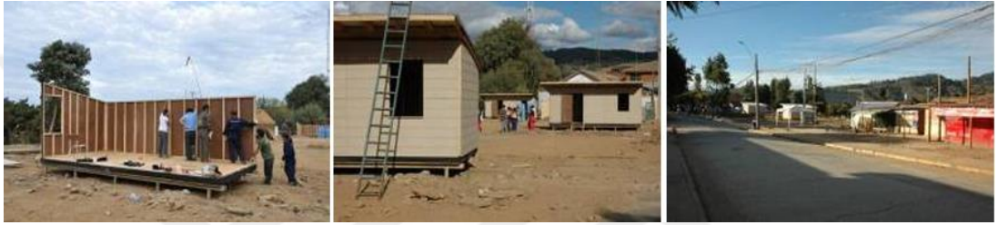
Şekil 3.22. 2010 Maule Depremi Sonrası Geçici Barınma Birimleri İnşaatı (Gobierno de Chile, 2010).
