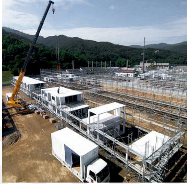
Şekil 3.24. Onagawa konteyner konutları inşaat süreci, Japonya (Url 16).
