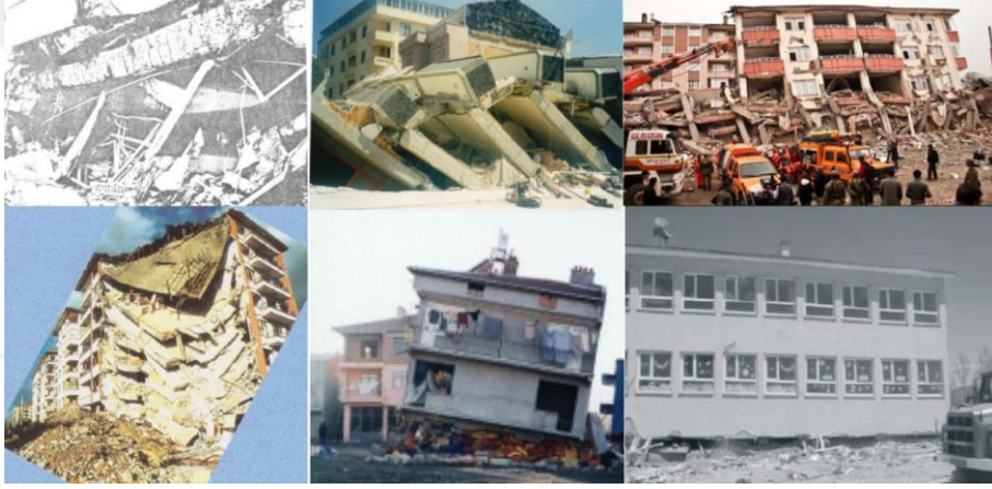
Şekil 3. Deprem sonrası 6 farklı hasar türünün gösterimi (Koç, 2016)
