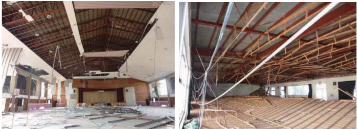
Şekil 2.21. Büyük Doğu Japonya Depremi'nde bir spor salonunun asma tavanının çökmesi (NILIM ve BRI 2011)
