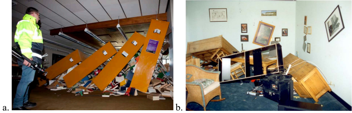
Şekil 2.35. a) 2010 Yeni Zelanda Depremi'nde çöken kütüphane rafları (FEMA 2011); b) 1994 Northridge Depremi'nde yaşanan konut hasarı (FEMA 2011)
