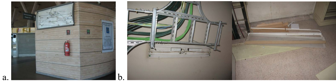
Şekil 2.42. a) 2010 Şili Depremi'nde duvara monte edilmiş aydınlatmanın yerinde kalmasına rağmen lens ve ampullerinin düşmesi (FEMA 2011); b) 2010 Şili Depremi'nde tavana monte edilmiş aydınlatmanın yerinde kalmasına rağmen merceğinin yetersiz bağlantılarla düşmesi (FEMA 2011)
