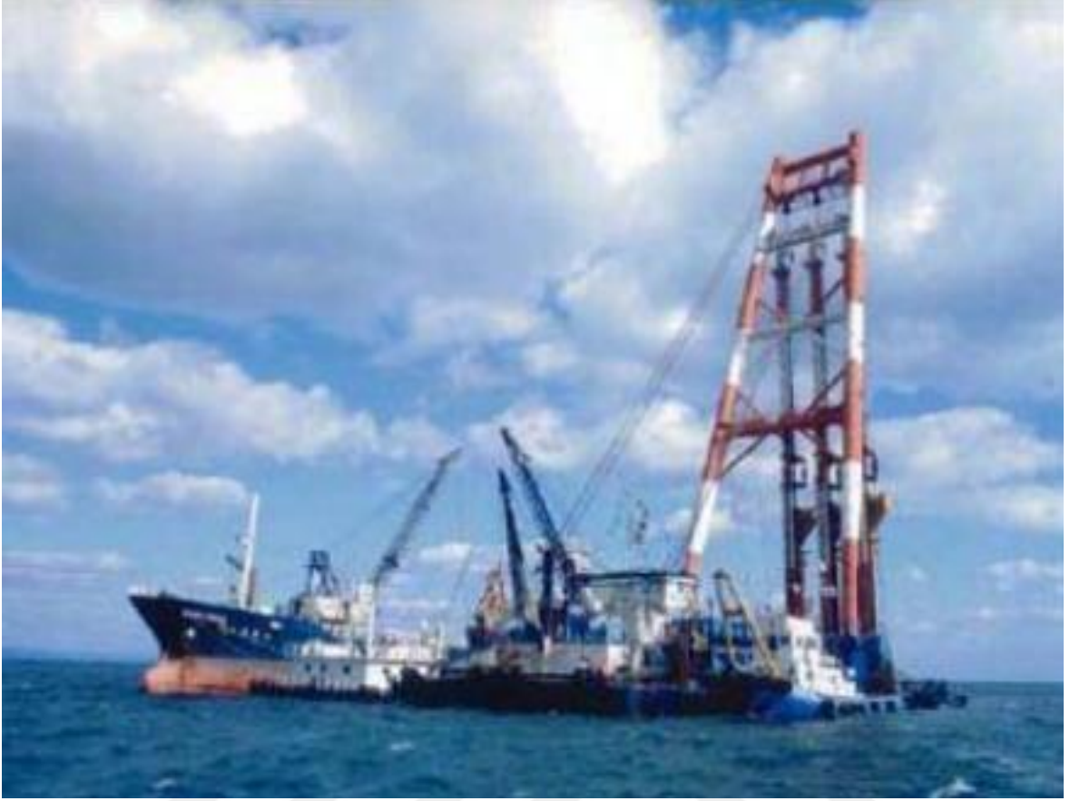
Görsel 2.9. Kum kompaksiyon kazıklarının denize yerleştirilmesi (Kitazume, 2007)
