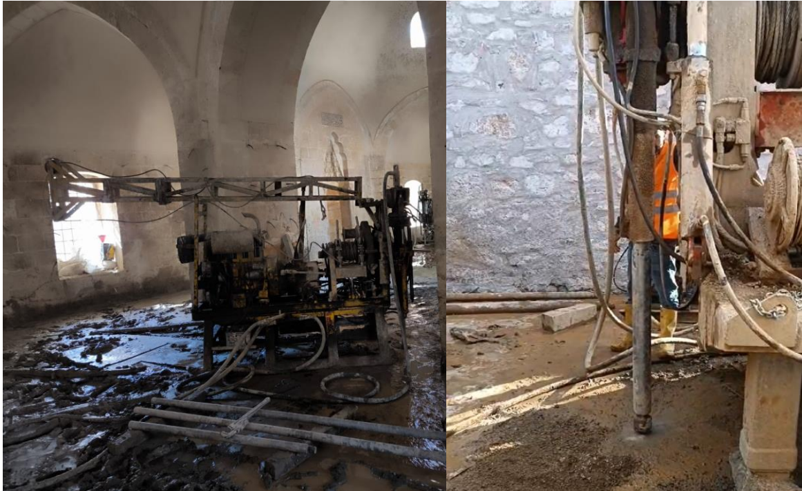
Görsel 4.1. Mikro kazık + enjeksiyon uygulaması delgi işlemi
