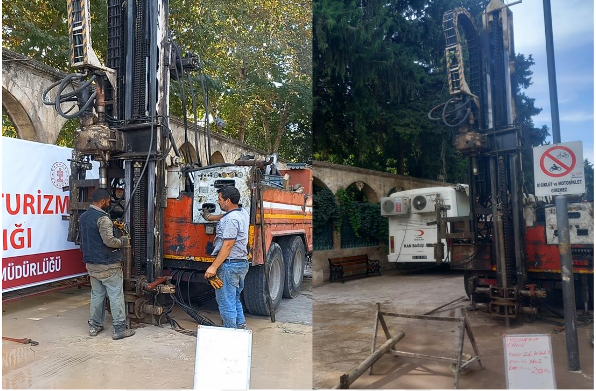
Görsel 3.2. Sondaj çalışmaları
