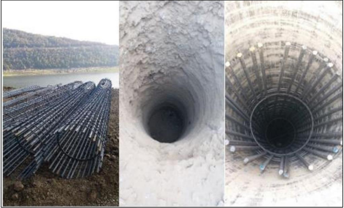
Görsel 2.4. a) Fore kazık donatısı b) Fore kazık çukuru c) Fore kazık donatı yerleşimi
