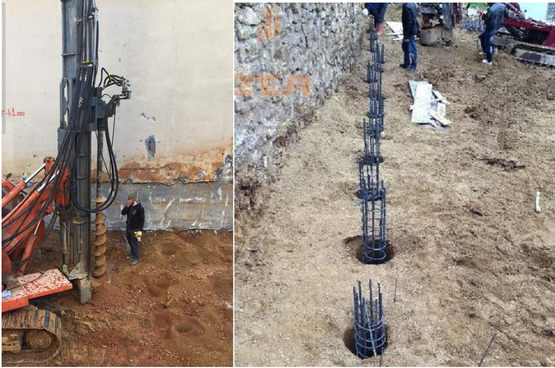
Görsel 2.6. Mini kazık delgisi ve donatı yerleştirilmesi
