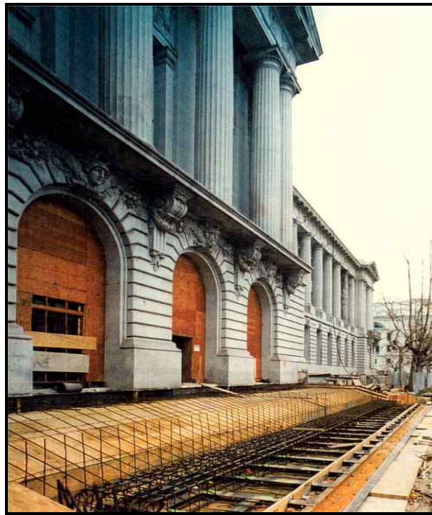
Resim 7.6. San Francisco City Hall binasında CLB sismik izolatr kullanımı.
