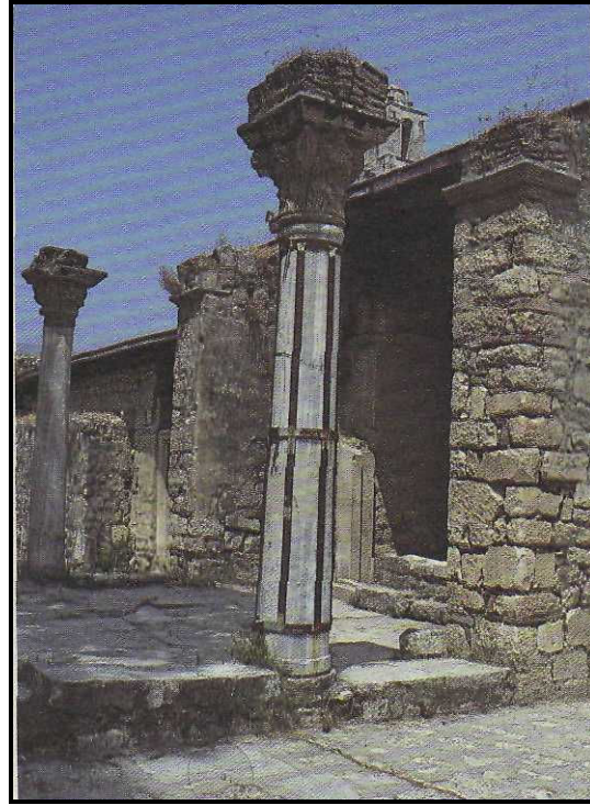
Resim 7.3. Çemberler ile kolonların desteklenmesi [8].
