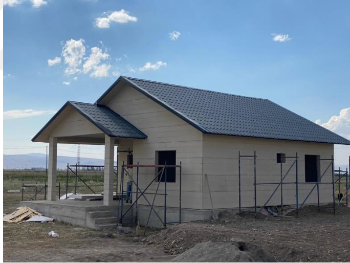
Şekil 6. Hafif Çelik Yapının Yalıtım ve Levhalarla Tamamlanmış Hali
