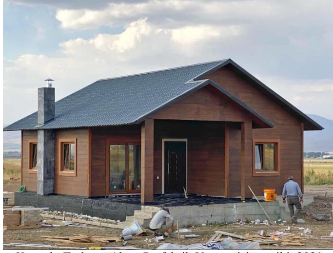
Şekil 7. Hafif Çelik Yapının Dış Kaplaması ve Çatısının Tamamlanmış Hali
