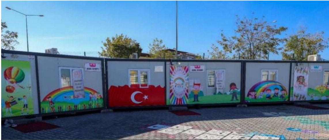
Şekil 20. Deprem Sonrası Açılan Prefabrik Okul (SBB, 2024)
