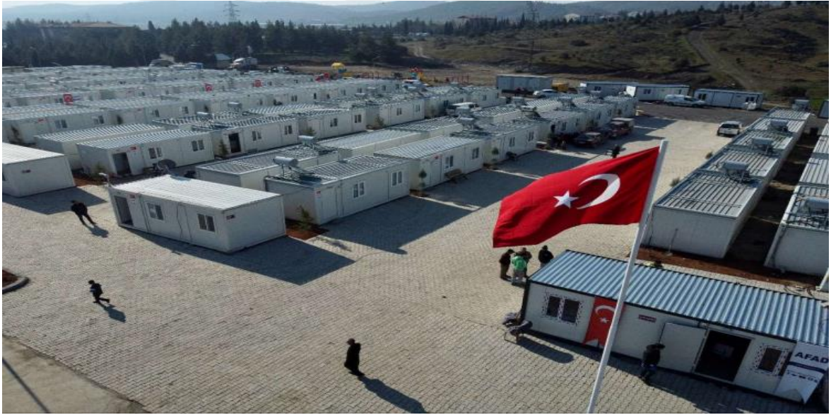
Şekil 3. Deprem Sonrası Oluşturulan Prefabrik Kent (SBB,2024)
