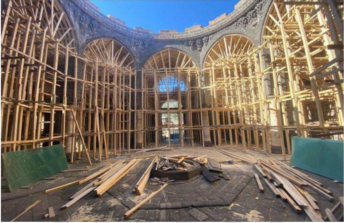
Şekil 8. Deprem Sonrası Tarihi Yapılarda Yapılan Restore İşlemi (SBB, 2024)
