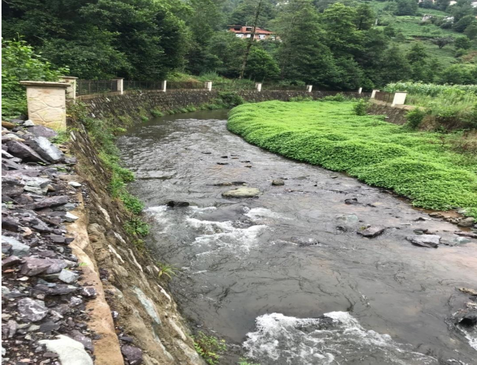
Ek 4. Kaldırılması gereken rusubat
