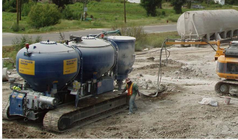
Şekil 2.6. Kuru karıştırma yönteminde kullanılan bağlayıcı sevkiyat ünitesi (Hayward Baker A.Ş.)
