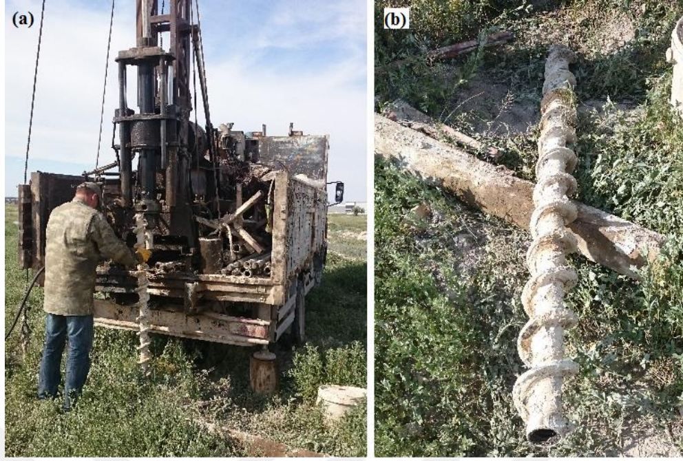
Şekil 3.1. a) Sondaj makinesi ile ilave sondaj kuyularının açılması, b) burgulu delici
