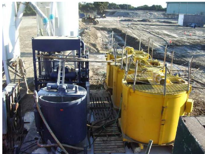
Şekil 2.5. DKK imalatında kullanılan beton santrali
