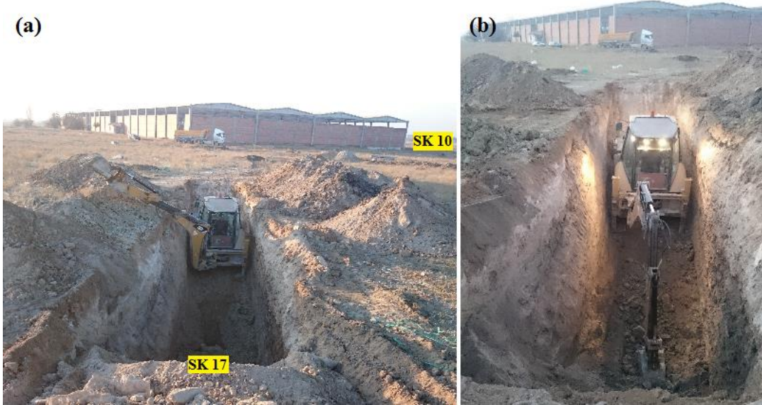
Şekil 3.2. a) İlave sondaj kuyularının yeri, b) yüzeyden 6 m derinlikten zemin hafriyatının yapılması
