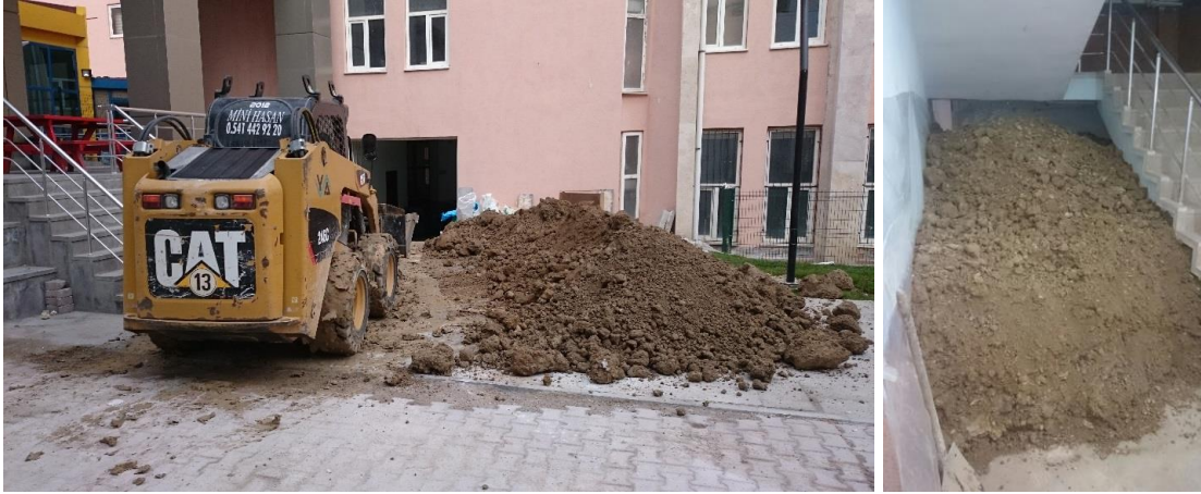
Şekil 3.3. a) Zeminin bina içerisine taşınması ve b) istiflenmesi
