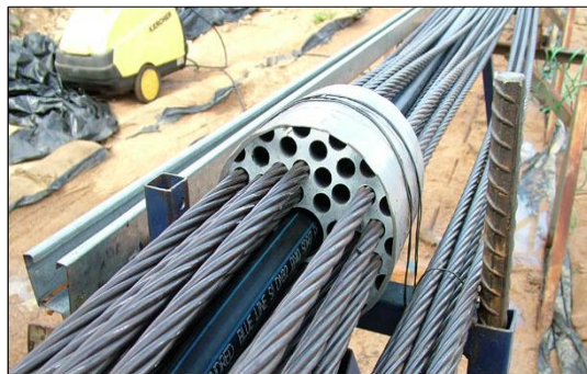
Şekil 2.5. Öngerme ankrajı olarak kullanılan çelik halat.
