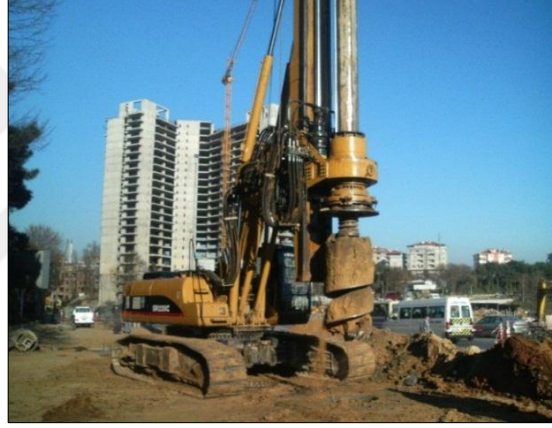
Şekil 2.1. Fore kazık delgi işlemi.
