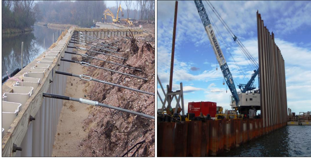
Şekil 2.10. Palplanş imalatı.
