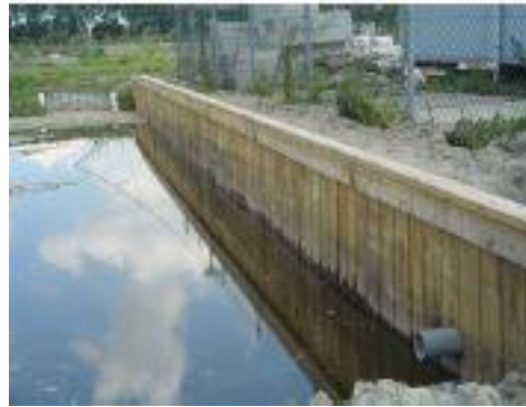
Şekil 3.18. Ahşap palplanş perde uygulaması
