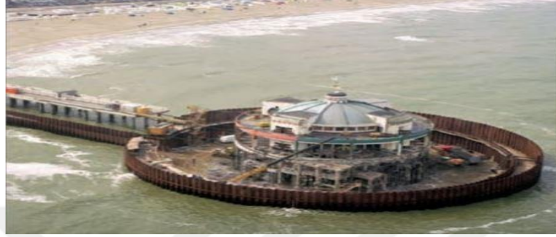
Şekil 3.20. Çelik palplanş perde uygulaması
