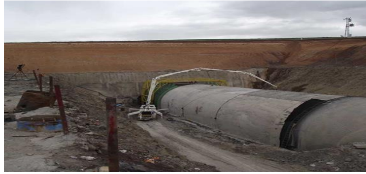
Şekil 3.5. Aç-kapa kazı yöntemi
