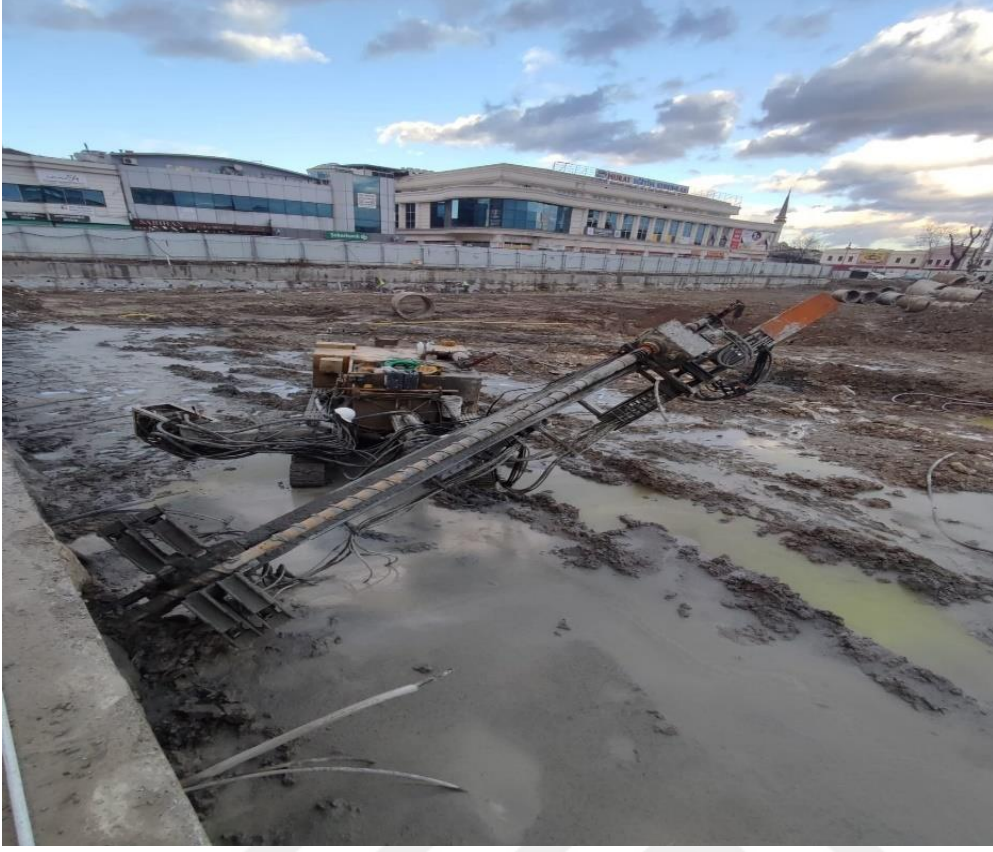
Şekil 6.14. Ankraj imalatı.
