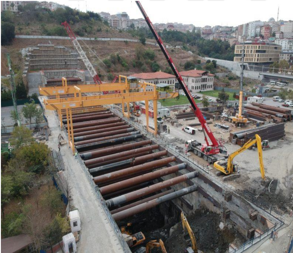
Şekil 5.6. Çelik borulu ( strut ) destek yapısında hafriyat çalışmaları.
