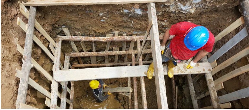
Şekil 4.6. Kuyu tipi duvar yöntemi.
