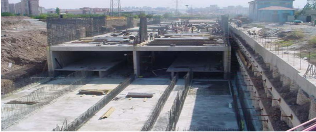
Şekil 4.5. Aç-Kapa kazı yöntemi.
