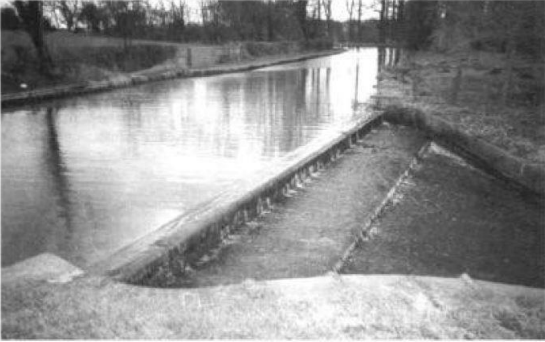
Şekil 3.5. İngiltere Leicester Bölgesinde su yolu üzerinde bulunan bir yan savak (May R. W. P. ve ark. 2003)
