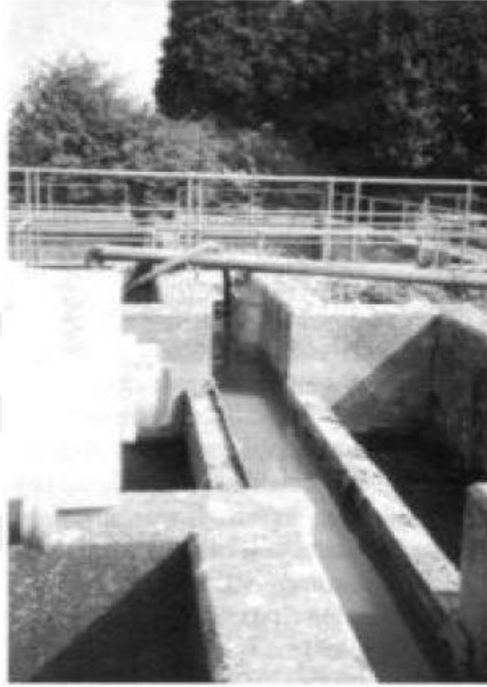
Şekil 3.3. İngiltere’de bulunan Stockley Arıtma Tesisi’ne ulaşan yan savak (May R. W. P. ve ark. 2003)
