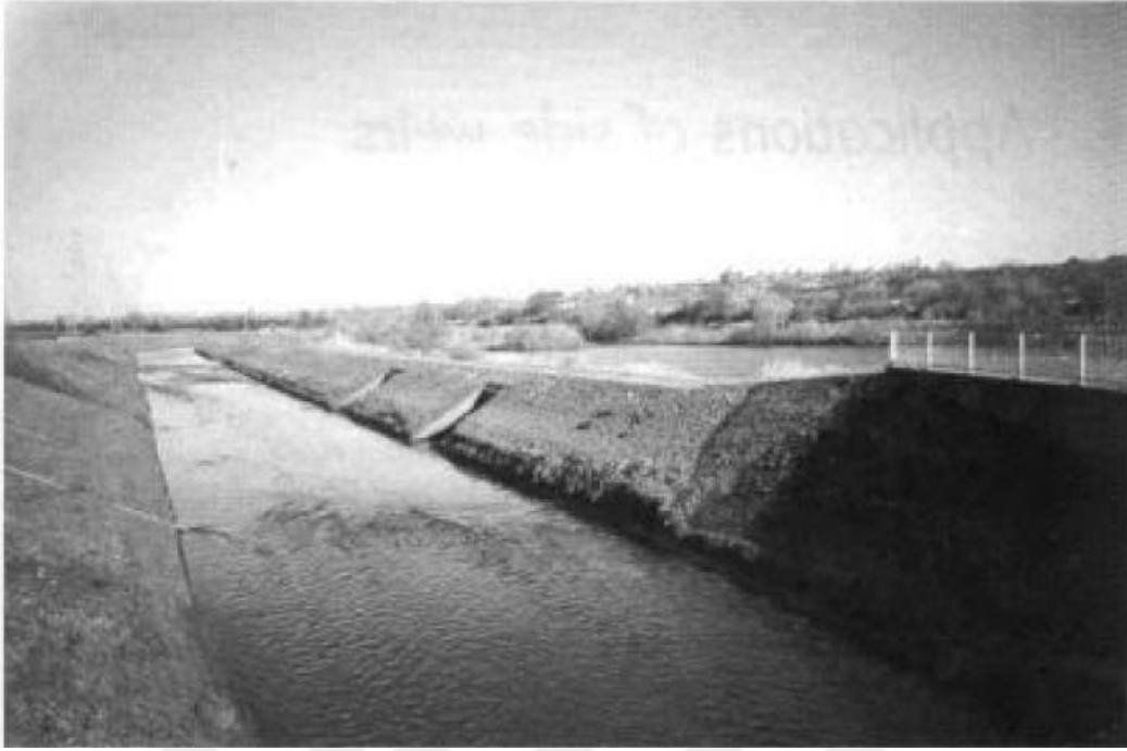
Şekil 3.1. İngiltere’de West Midlands bölgesinde bulunan Tame Nehri üzerinde inşa edilmiş Sandwell Savağı (May R. W. P. ve ark. 2003)
