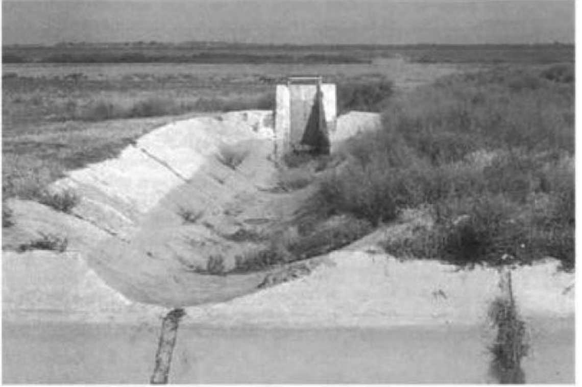
Şekil 3.2. Kazakistan Maktaral Bölgesi'nde inşa edilmiş yan savak (May R. W. P. ve ark. 2003)
