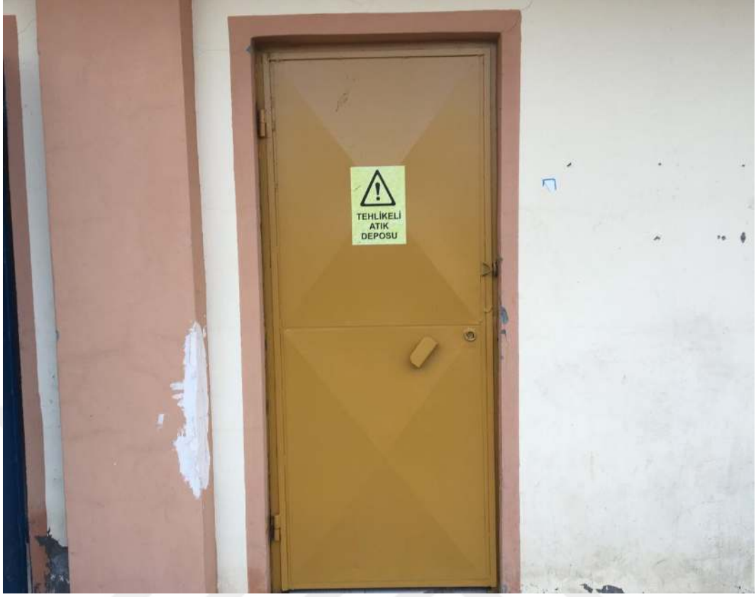
Şekil 4.20. Sıvı içerikli tehlikeli atık deposu
