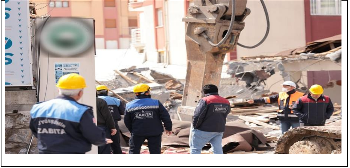
Şekil 5.7: İBB Zabıtası Ekiplerince Yıkım Çalışmaları.
