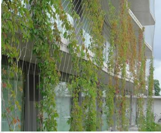
Görsel 4.5. Güneş ışığı kontrolü ile sıcaklığın düşmesine sebep olan yeşil cephe örneği ( http-62 )
