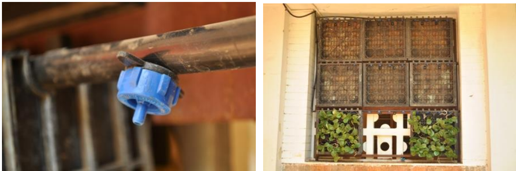
Görsel 3.18: Damlama sulama ve damlama yöntemi ile sulanan dikey yeşil sistem ( http-36 )
