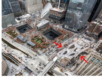
Görsel 5.27. Liberty Park yapım aşaması (http-98)
