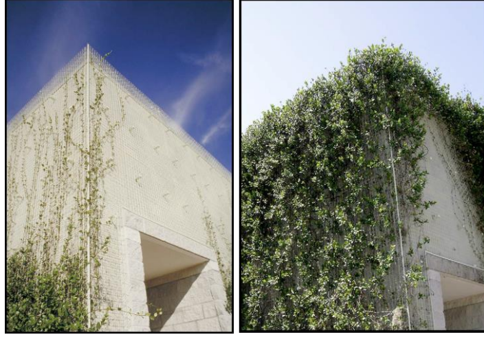
Görsel 3.2. Modüler kafes panel sistemi ile bitkilendirilen yapı duvarı (http-21)
