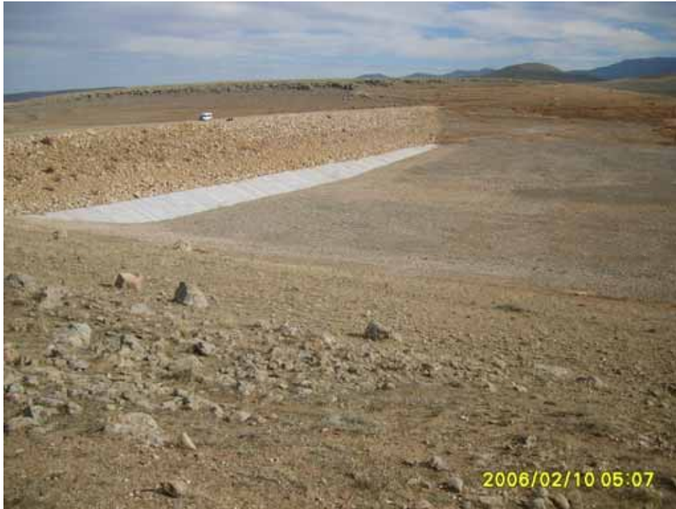
Şekil 4.49. Rezervuar alanının kil örtü ile kaplanmış son hali
