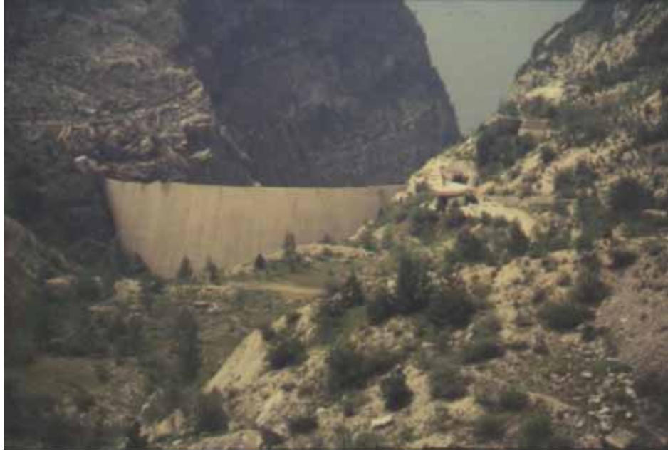
Şekil 1.10. Vaiont rezervuarının heyelan malzemesiyle dolmuş hali (Ertunç, 2003)
