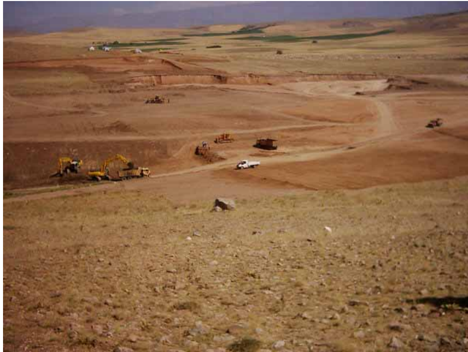
Şekil 4.28. Mekanik stabilizasyon işlemlerinin başlanması
