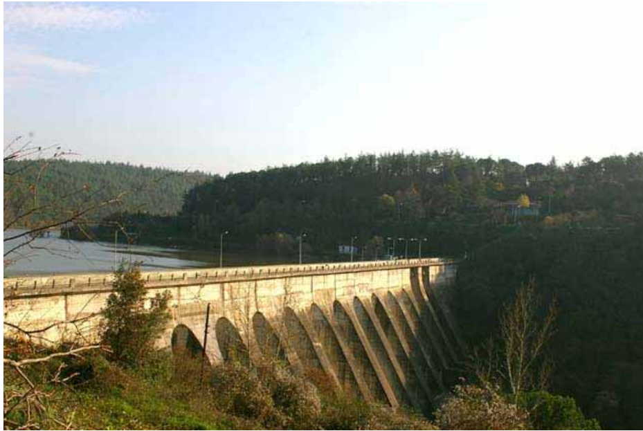
Şekil 1.2. Payandalı ağırlık barajına örnek Elmalı Barajı ( www.photoshopmagazin.com )
