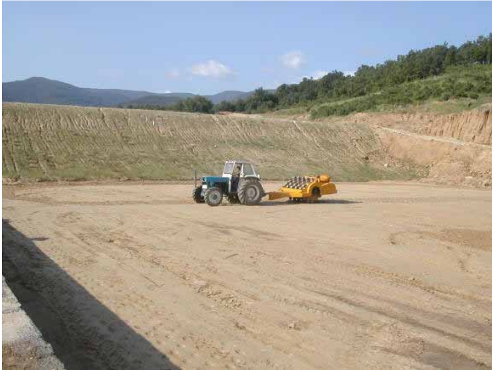
Şekil 4.27. Yunanistan Kolhiki Barajında uygulanan sıkıştırılmış kil örtü çalışması (www.geoservice.gr)
