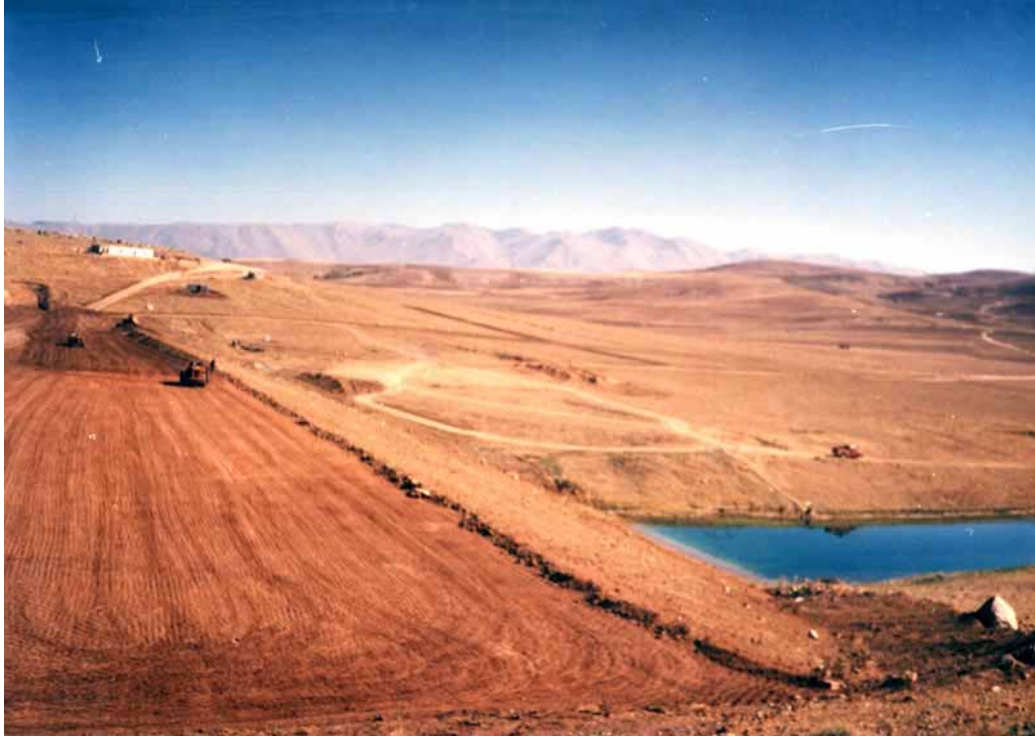
Şekil 4.4. Dikilitaş Gölet’i ana gövde inşası ( www.ozbulutinsaat.com )
