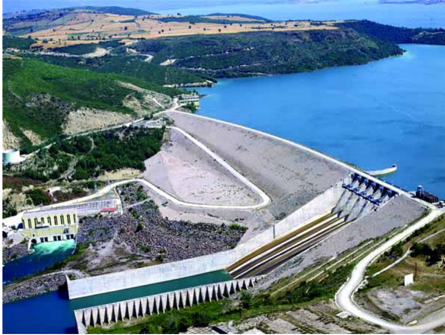
Şekil 1.5. Aslantaş Barajı ( www.yeniresim.com )
