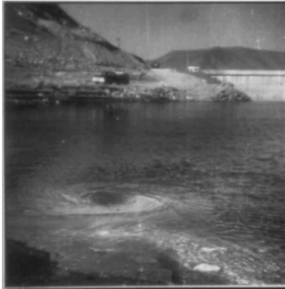
Şekil 1.12. Keban Barajı sol yamaç Petek Mağarası'ndan su kaçaqları (Ertunç, 2003)
