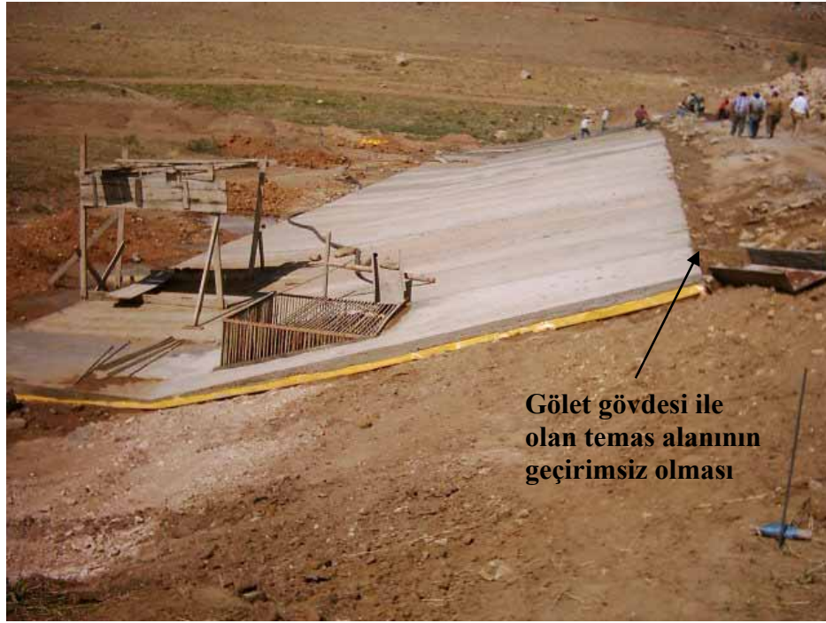
Şekil 4.29. Kil örtünün gölet ana gövdesi ile olan dokanağında yapılan çalışma
