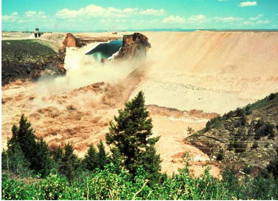
Şekil 1.9. Teton Barajı'nın yıkılışı ( www.geol.ucsb.edu )
