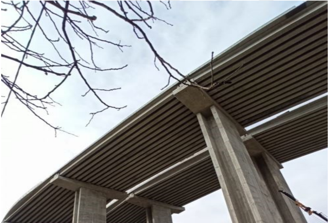
Şekil 1.14. Prekast kirişli köprü(Karşıyaka Viyadüğü)
