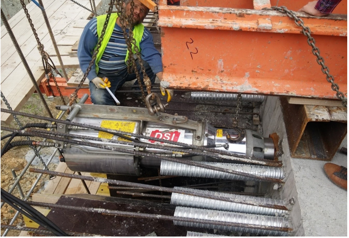
Şekil 1.27. Ardgerme çekim işlemi
