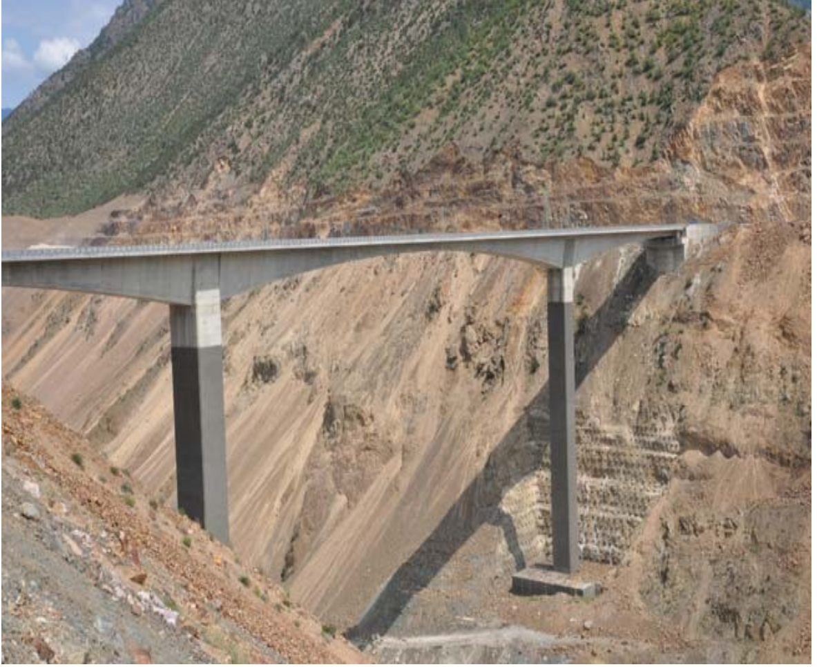
Şekil 1.16. Dengeli konsol örneği (Berta Köprüsü)
