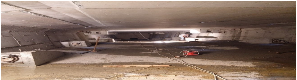
Şekil 1.25. Dengeli konsol tabliye iç görünüşü
