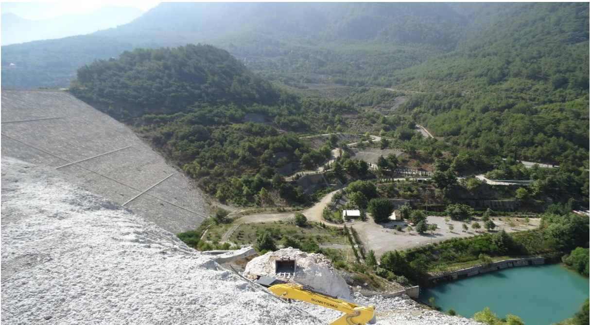
Fotoğraf 1.3 Dim Baraj Duvarı (16.08.2017)
