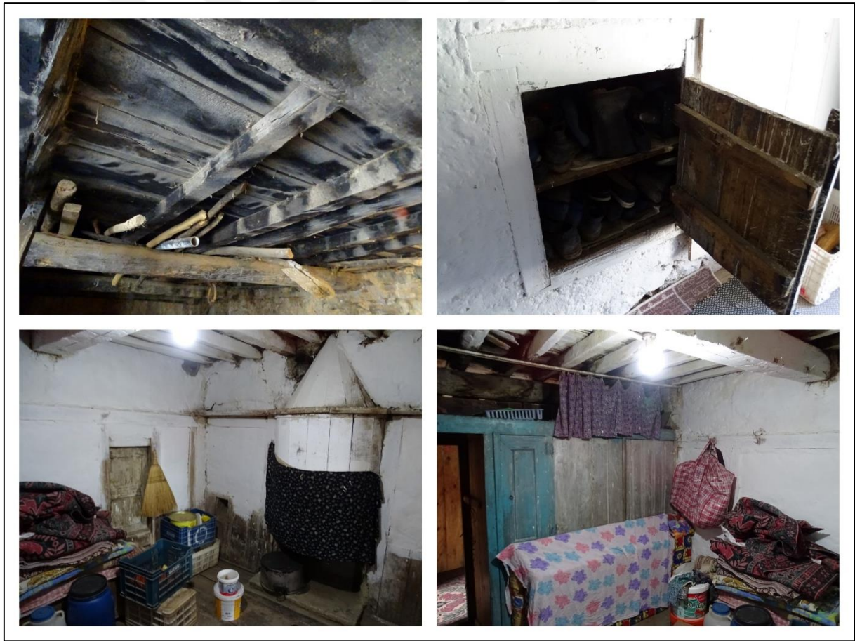
Fotoğraf 2.12 Taş Meskenlerde Kullanılan Ahşap Malzemeler (17.02.2018)
