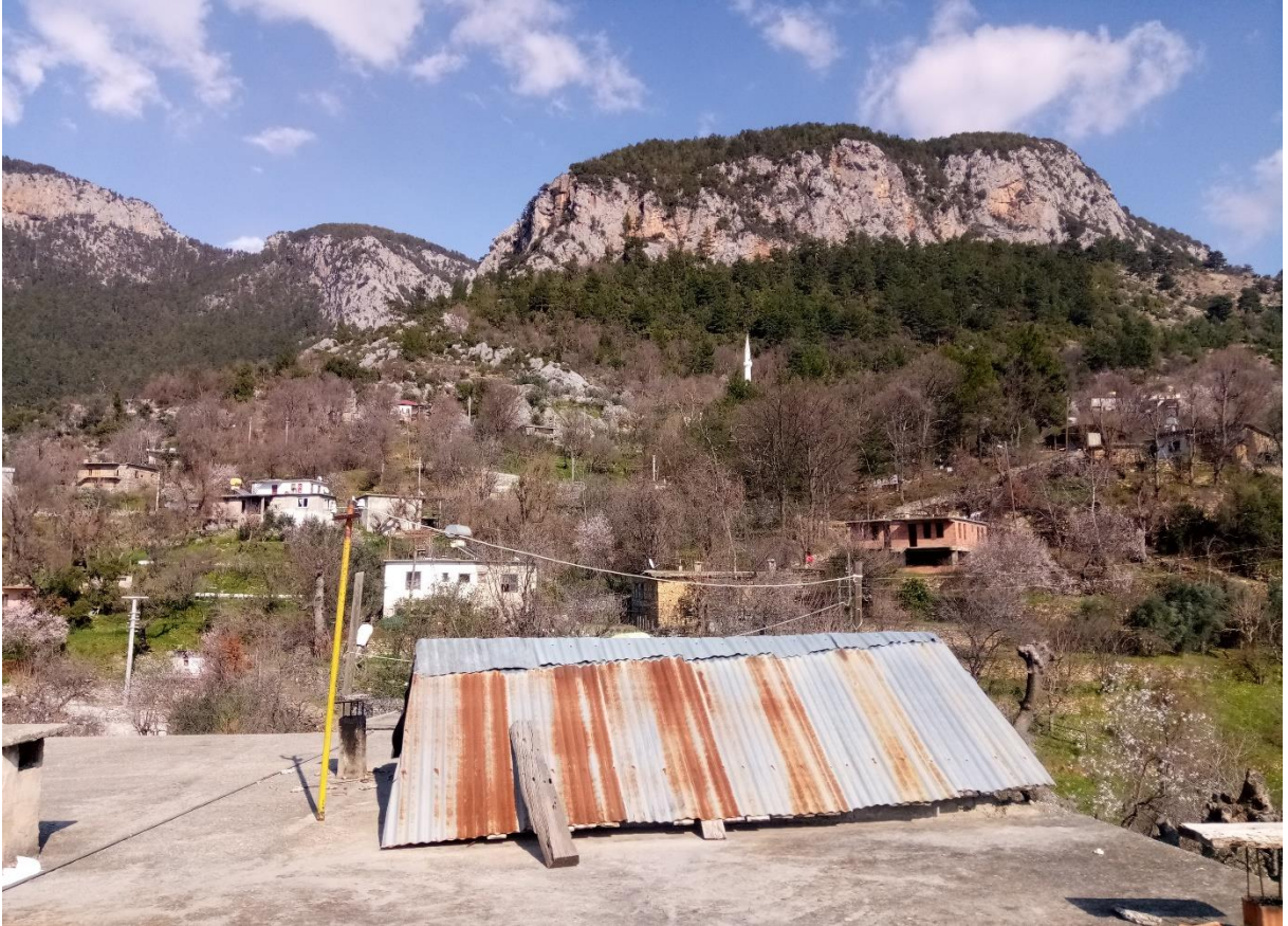
Fotoğraf 2.11 Taşbaşı Mahallesiinde Dam Örneği (17.02.2018)
