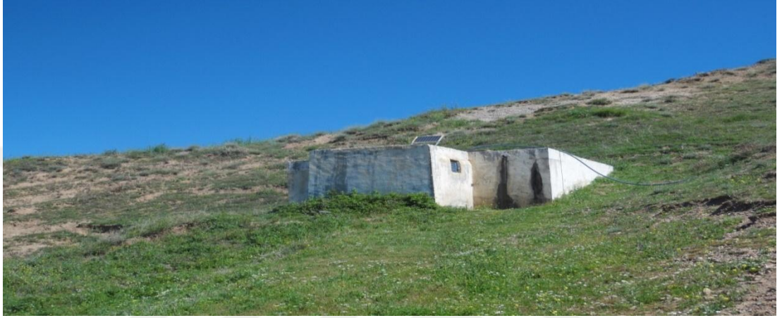
ÇARDAK KÖYÜ SU DEPOSU
