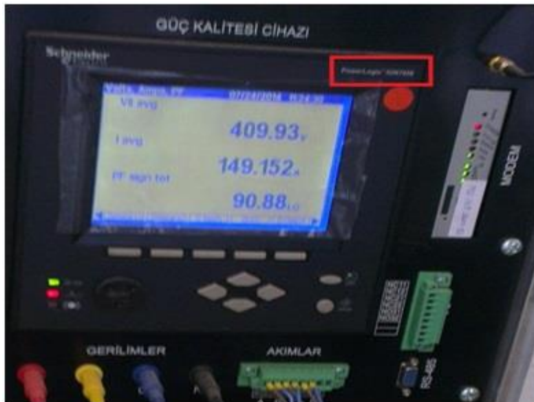
Resim 6.1. ION 7650 Güç kalitesi analizörü ve baralara bağlantısı görüntüleri
