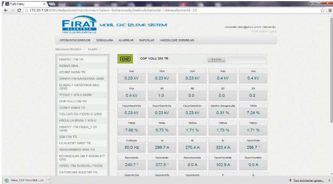
Şekil 6.19. Ölçüm noktası 2, transformatör anlık ayrıntılı ölçüm bilgileri
