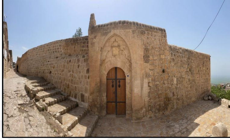
Şekil 4.38 Mort Şmuni Kilisesi Giriş Cephesi (Tunçay F. Arşivi 2023)
