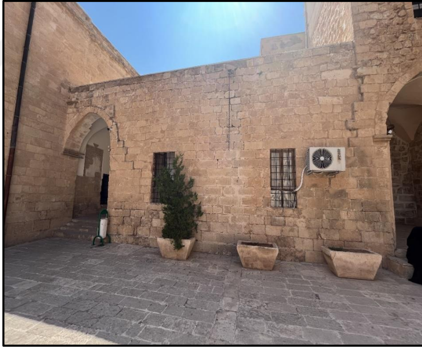
Şekil 4.89 Mardin Ulu Cami Batı Cephesinde Bulunan Revaklar (Tunçay F. Arşivi 2023)
