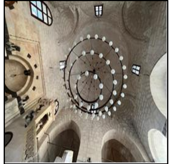
Şekil 4.138 Latifiye Cami Kubbe Kasnağında Bulunan Pencereler a) Çizim b)Fotoğraf Çizim (Mimardin Mimarlık Arşivi 2023), (Tunçay F. Arşivi 2023)
