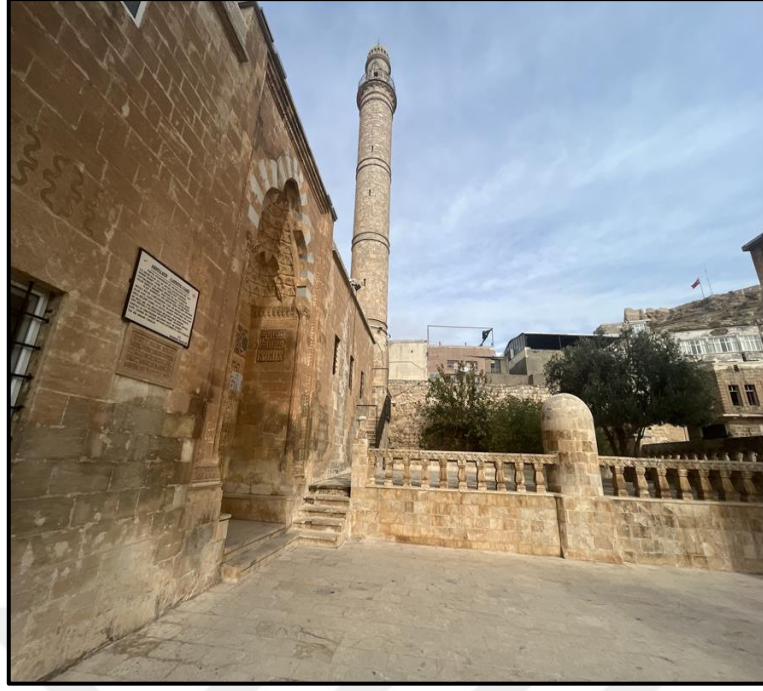
Şekil 4.118 Latifiye Cami Birinci Avlu Kuzey Cephesi (Tunçay F. Arşivi 2023)
