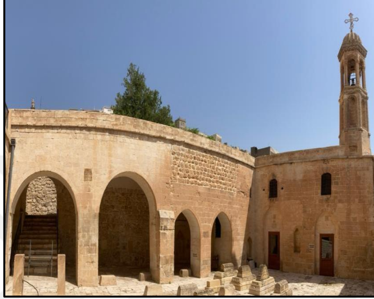
Şekil 4.36 Mort Şmuni Kilisesi Avlu Kuzey Cephesi Revak Kısımı (Tunçay F. Arşivi 2023)
