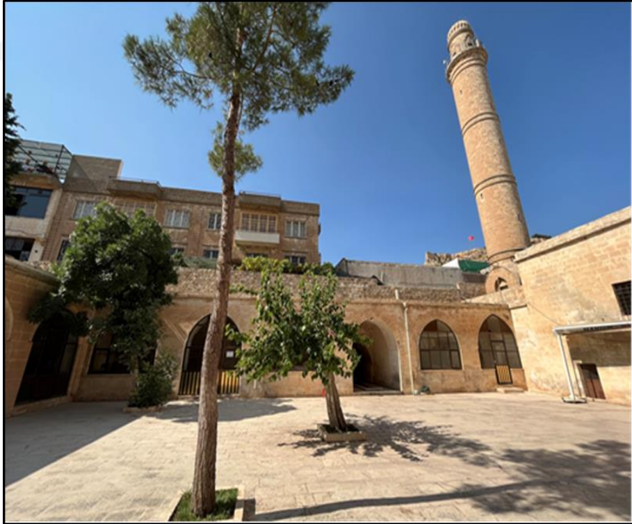
Şekil 4.121 Latifiye Cami İkinci Avlu Kuzey Cephesi ( Tunçay F. Arşivi 2023)
