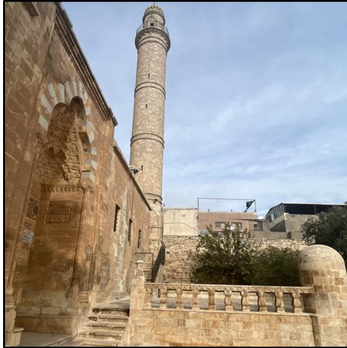
Şekil 4.133 Latifiye Cami Minare Giriş Merdiveni (Tunçay F. Arşivi 2023)
