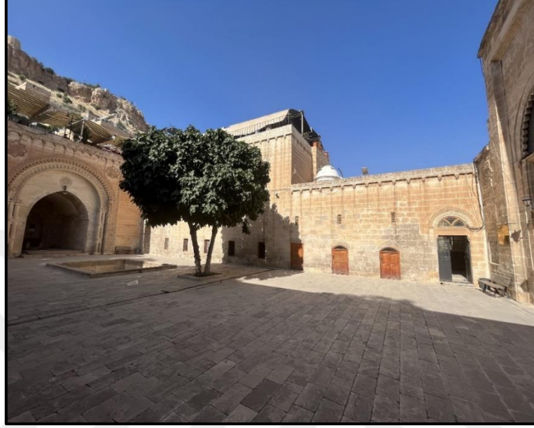
Şekil 4.153 Şehidiye Cami Avlu Dođu Cephesi (Tunçay F. Arşivi 2023)
