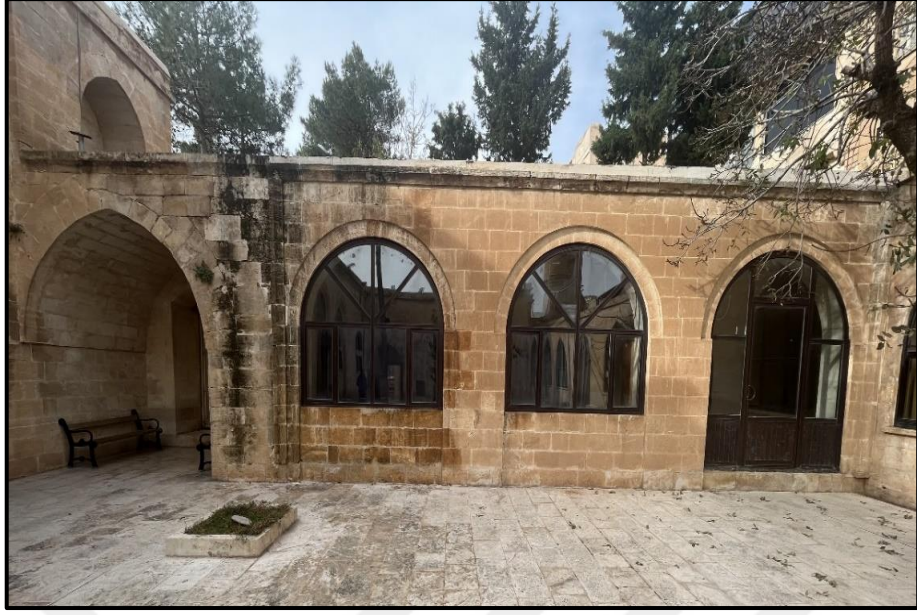
Şekil 4.126 Latifiye Cami İkinci Avlu Batı Cephesi Revaklar (Tunçay F. Arşivi 2023)
