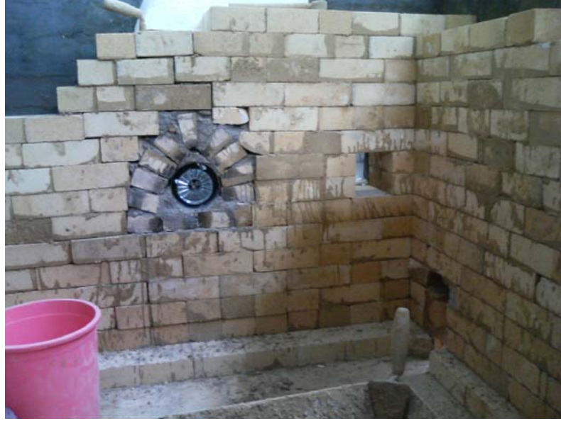
Resim 5.8. Fırın brülör, gözetleme deliği ve akış ağzının gösterimi
