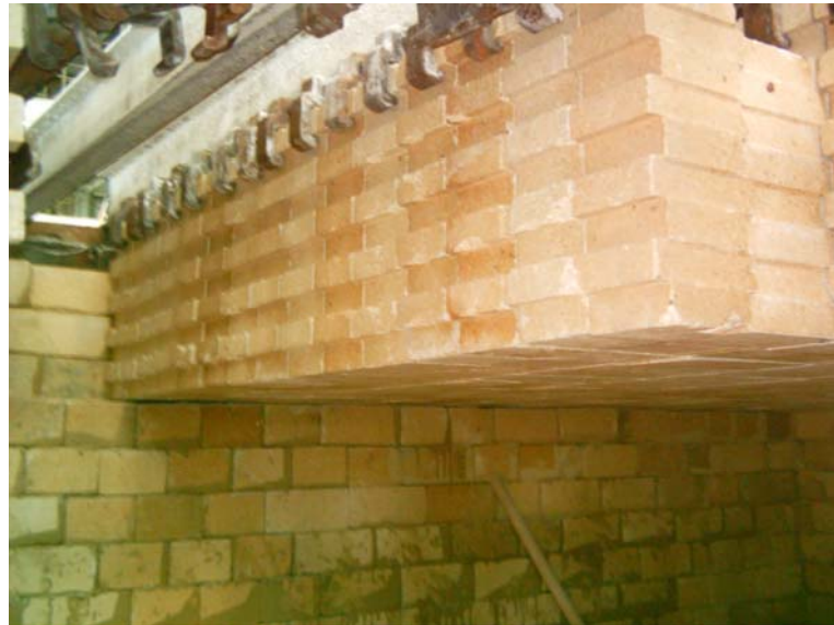
Resim 5.9. Fırın asma tavan örümü
