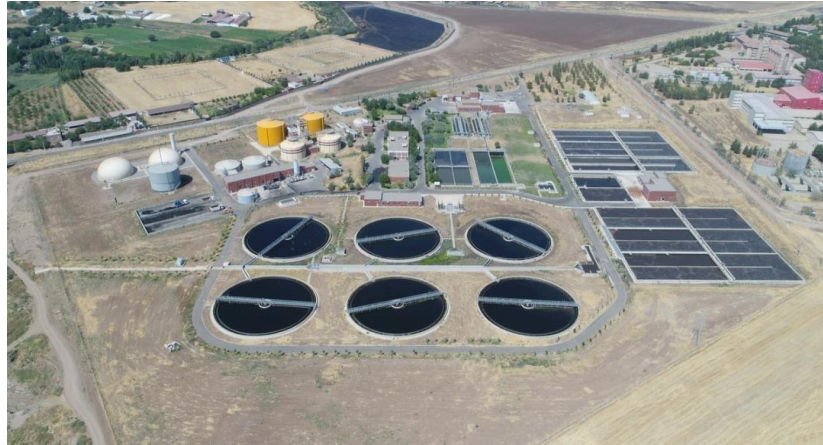
Şekil 3.4 Diyarbakir ileri biyolojik arıtma tesisi (DİSKİ, 2024)
