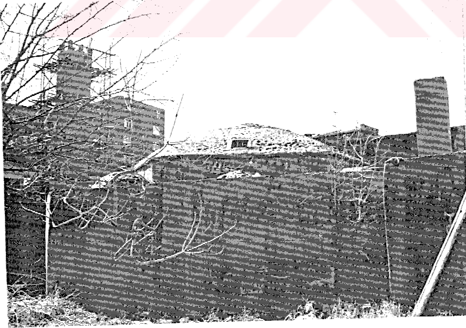
Şekil 4.19. Doğu cephesi sıcaklık duvarı ve kubbesi
