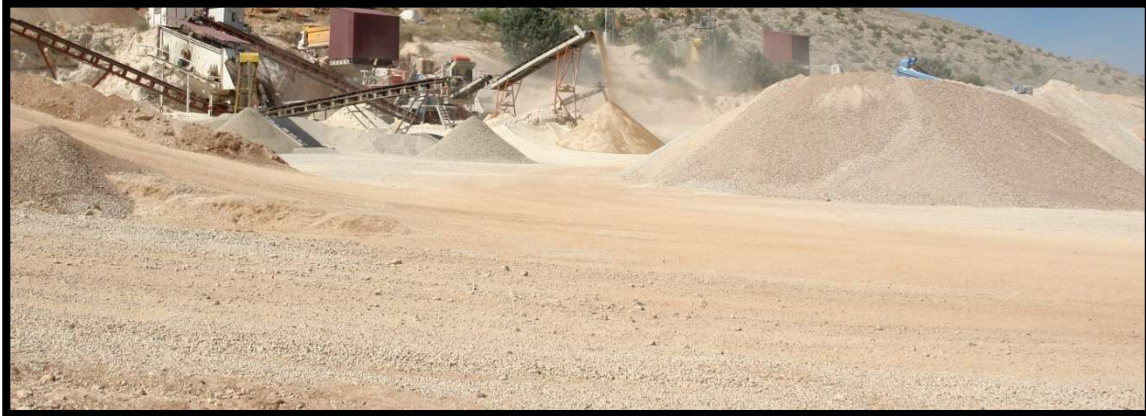
Şekil 3.10. Petekkaya (Nişinig) Ocağının görüntüsü
