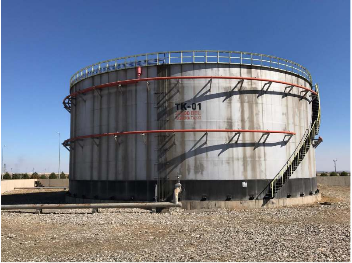
Şekil 3.11. Kurkan İstasyonundaki 35000 varil kapasiteli taşıma tankı
