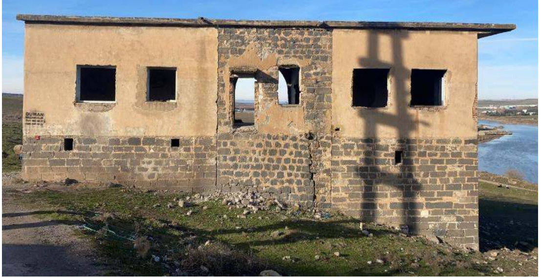
Şekil 4.71 Yapı güney cephesi
