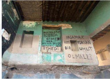
Şekil 4.45 K01 oda güney yüzeyi
