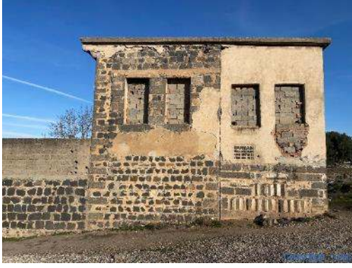
Şekil 4.117 Batı cephesi sıva
