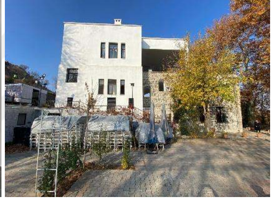
Şekil 3.19 Gazi Köşkü güney cephe (2022)
