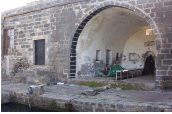
Şekil 3.50 Bekir Paşa Köşkü genel görünüm (Çiftçi, 2007)
