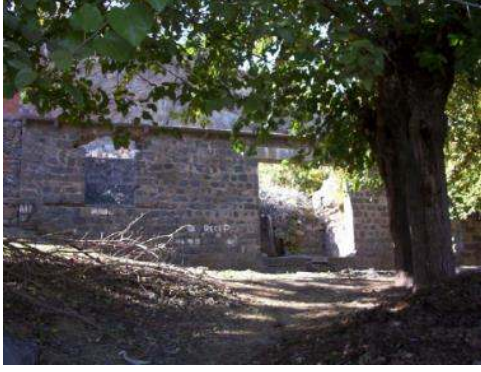
Şekil 3.52 Bekir Paşa Köşkü genel görünüm (Çiftçi, 2007)
