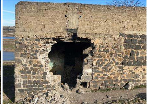
Şekil 4.67 Batı cephe kuzey kanadı
