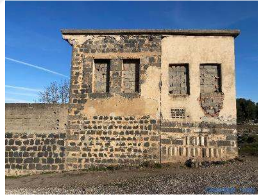
Şekil 4.123 Batı cephe kapatılan özgün açıklıklar
