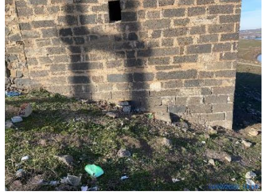
Şekil 4.73 Yapı kuzey cephesi sağ kısım
