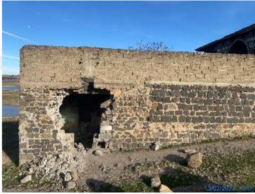
Şekil 5.9 Avlu batı duvarı (yapı batı cephesi)
