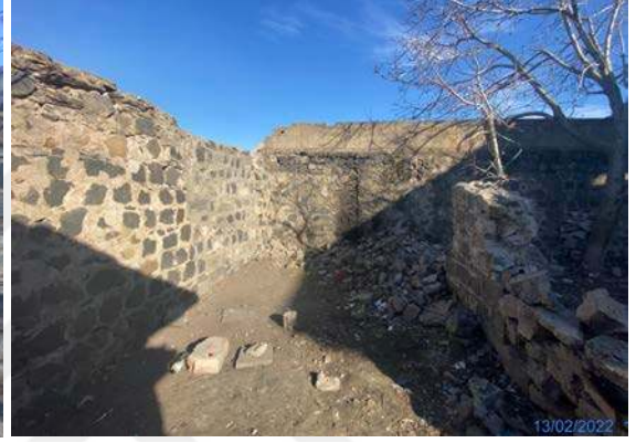
Şekil 5.22 Z11 oda doğu duvarı
