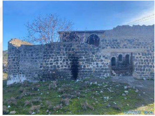
Şekil 4.116 Kuzey cephesi derz yapılması
