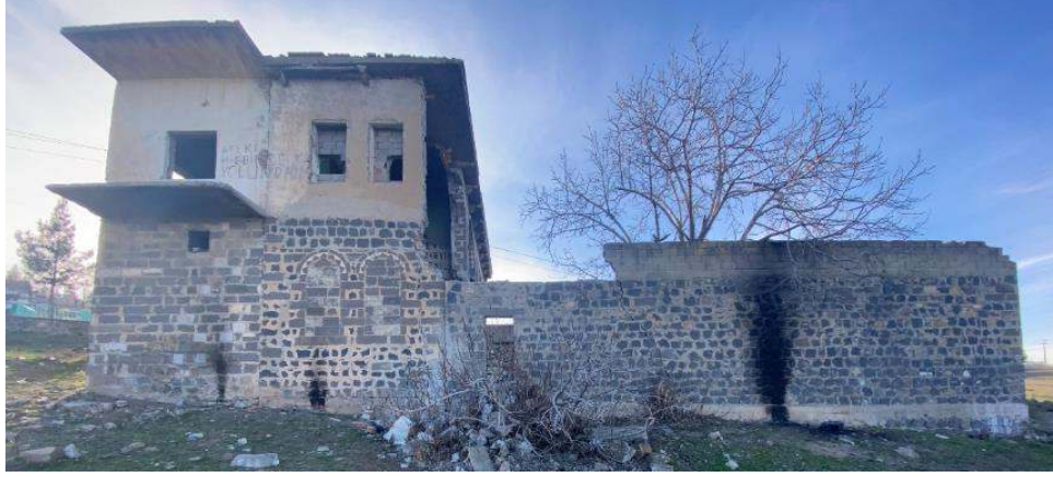
Şekil 4.68 Yapı doğu cephesi
