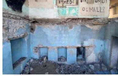
Şekil 4.14 Z01 oda güney yüzeyi
