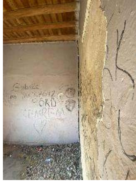
Şekil 5.16 K04 oda batı yüzeyi
