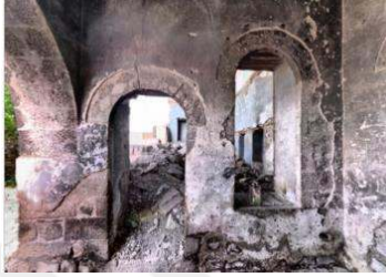
Şekil 4.13 Z01 oda girişi (batı cephe)
