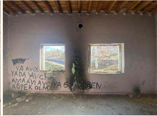
Şekil 4.54 K04 oda güney yüzeyi
