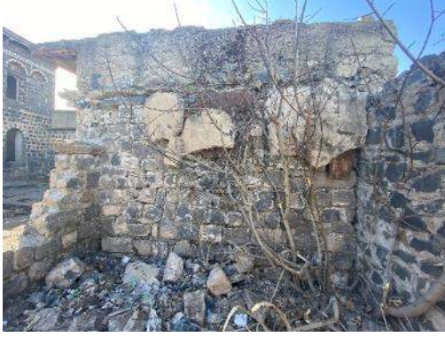
Şekil 4.109 Z11 kuzey duvarı
