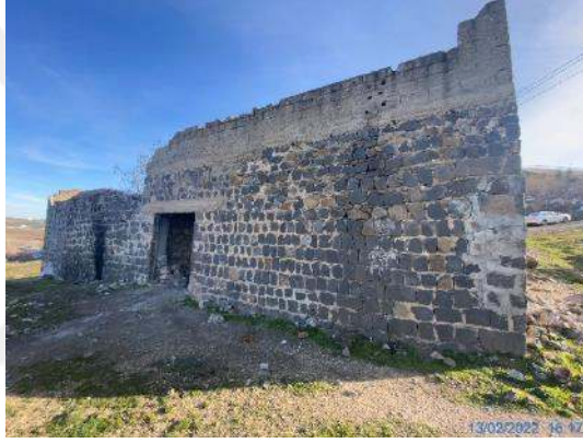
Şekil 4.63 Yapı kuzey cephesi
