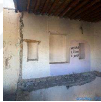
Şekil 4.50 K03 oda güney yüzeyi
