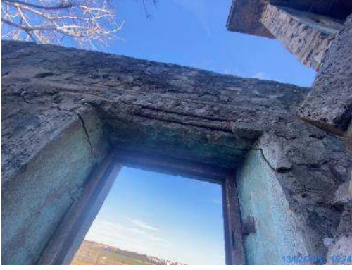
Şekil 4.127 Doğu cephe kapı kasası
