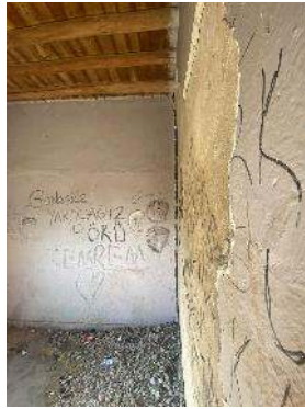
Şekil 4.53 K04 oda batı yüzeyi
