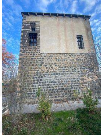
Şekil 3.23 Erdebil Köşkü batı cephe (2022)
