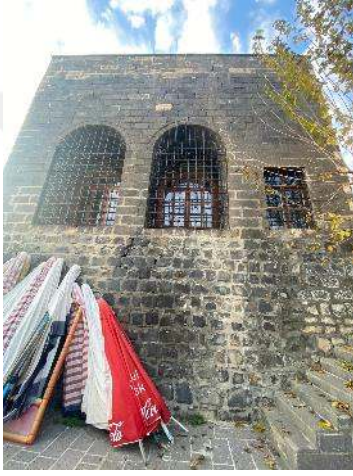
Şekil 3.22 Erdebil Köşkü doğu cephe (2022)
