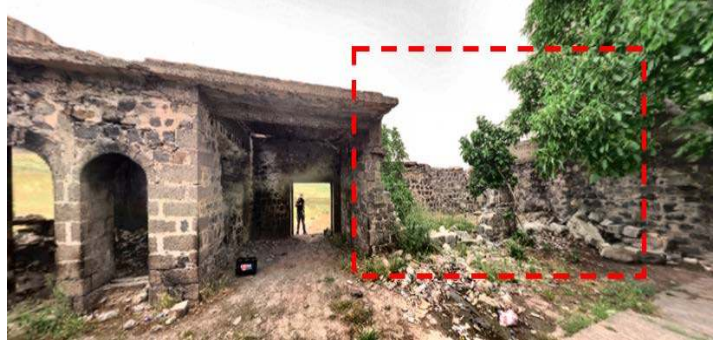
Şekil 4.38 Z11 odanın yapıdaki konumu
