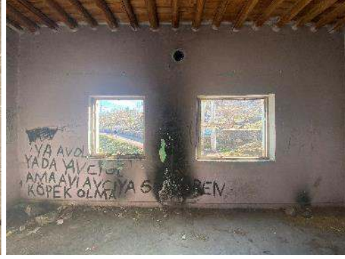
Şekil 5.17 K04 oda güney yüzeyi
