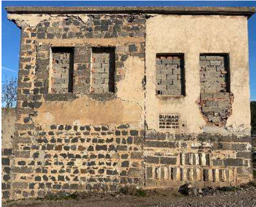
Şekil 4.66 Batı cephe güney kanadı
