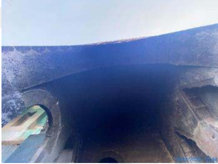
Şekil 4.18 Z02 eyvan kemeri alttan görünüşü
