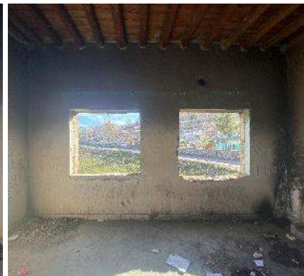
Şekil 5.20 K06 oda güney cephe
