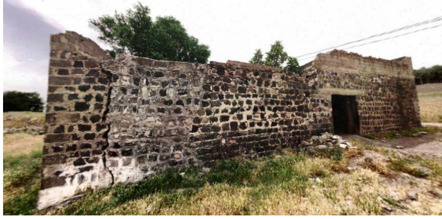
Şekil 4.62 Yapı kuzey cephesi
