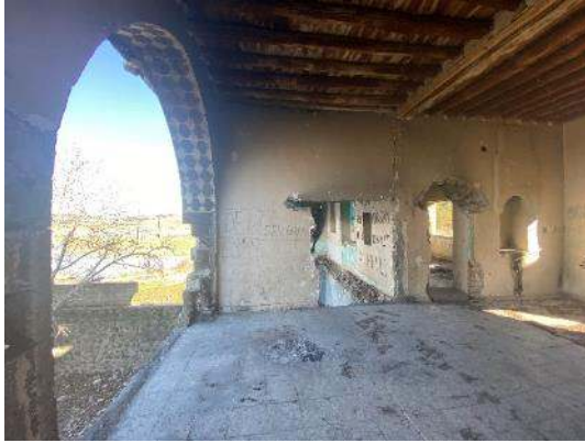
Şekil 4.43 a) K02 eyvan doğu yüzeyi
