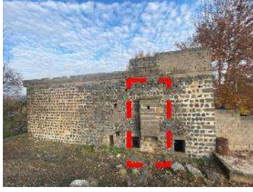
Şekil 3.36 Kuşdili Köşkü batı cephe (2022)
