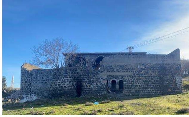
Şekil 5.8 Z10 kuzey cephesi (yapı kuzey cephesi)
