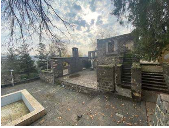
Şekil 3.29 Hami Köşkü eyvan ve merdiven girişi (2022)
