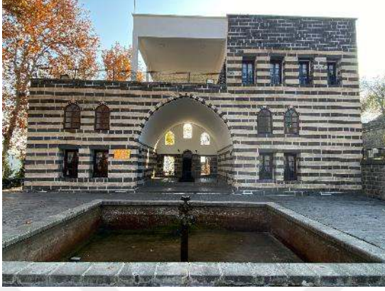
Şekil 3.16 Gazi Köşkü kuzey cephe (2022)
