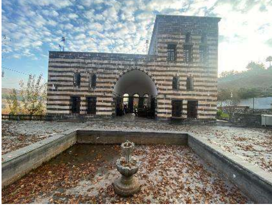
Şekil 3.20 Erdebil Köşkü kuzey cephe (2022)
