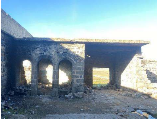
Şekil 4.111 Z10 güney duvar pencere kemerleri
