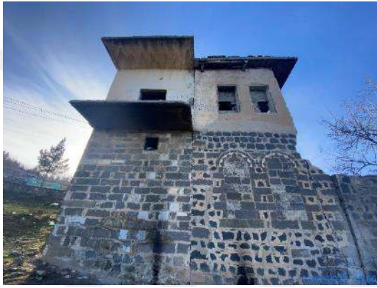
Şekil 4.69 Doğu cephe güney kütlesi
