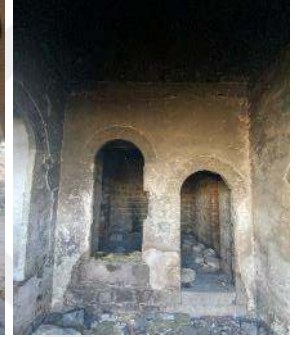
Şekil 4.20 Z02 eyvan güney yüzeyi
