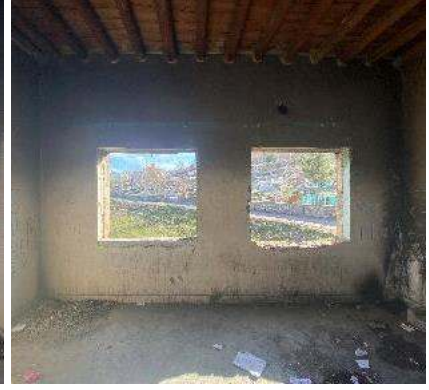
Şekil 4.58 K06 oda güney yüzeyi
