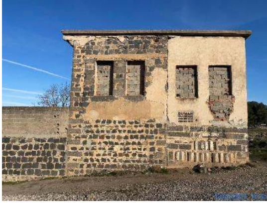
Şekil 4.115 Batı cephesi derz yapılması
