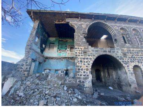
Şekil 4.60 Kuzey cephesi (güney kanadı)
