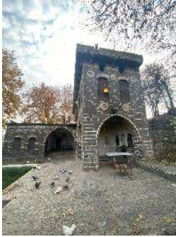
Şekil 3.32 Kuşdili Köşkü kuzey cephe (2022)
