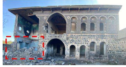
Şekil 4.12 Z01 oda konumu ve kuzey cephesi
