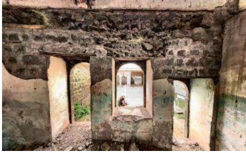
Şekil 4.24 a) Z04 oda kuzey cephe
