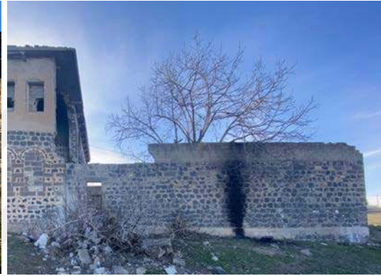
Şekil 5.10 Avlu doğu duvarı (yapı doğu cephesi)
