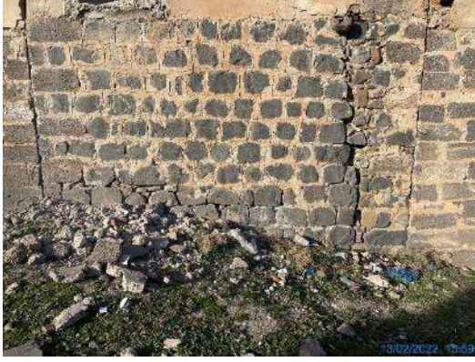
Şekil 4.72 Yapı güney cephesi orta kısım
