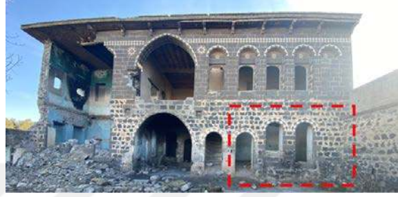
Şekil 4.23 Z04 odanın yapıdaki konumu
