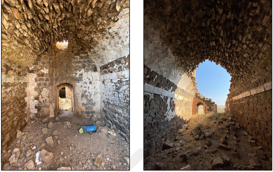
Şekil 4.13 ZK-02 Numaralı odanın güney ve kuzey duvarı
