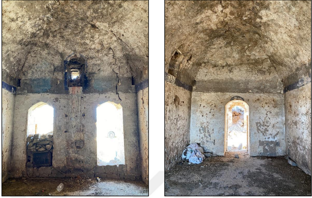
Şekil 4.18 ZK-04 Numaralı odanın güney ve kuzey duvarı
