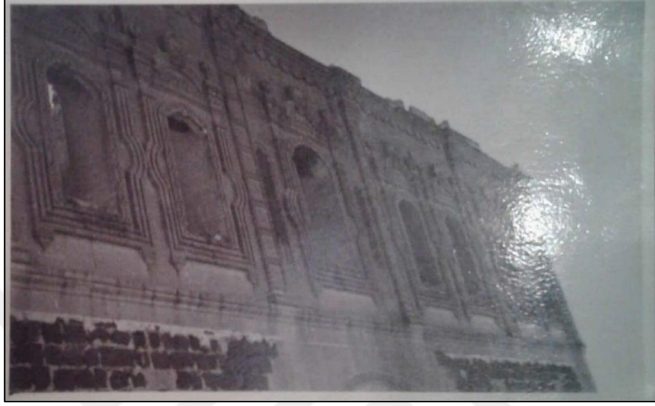
Şekil 5.23 BK-01 numaralı odanın 1989 öncesi durumu (Köy Ahalisinden)
