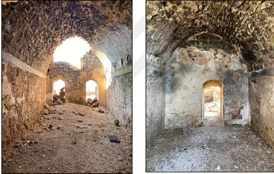
Şekil 4.20 ZK-05 Numaralı odanın güney ve kuzey duvarı
