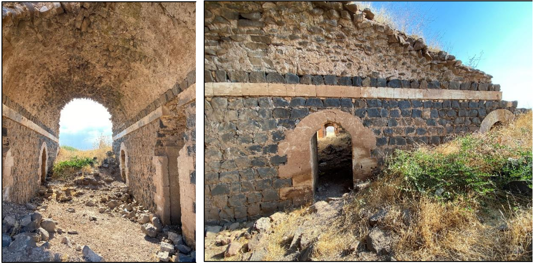
Şekil 5.16 Tonoz ve duvar detayları
