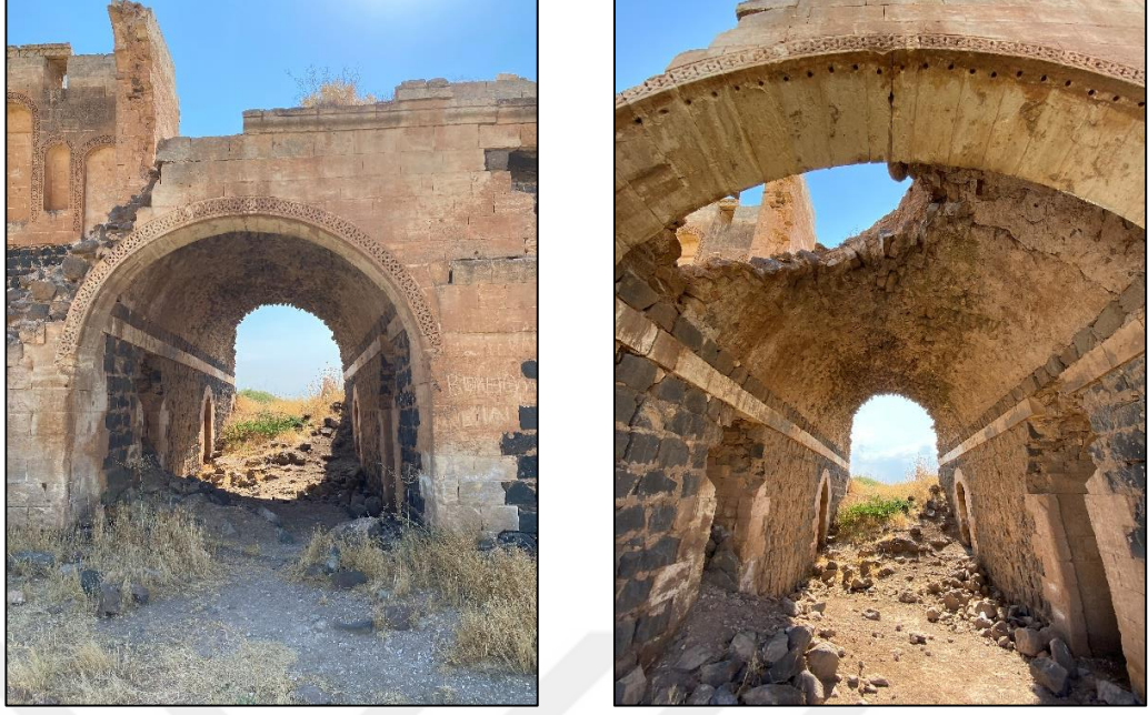
Şekil 4.8 Yapıya ulaşımı sağlayan batı girişi ve dehliz
