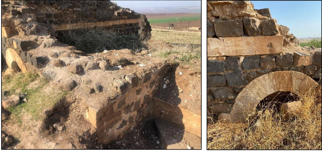
Şekil 4.15 ZK-03 Numaralı odanın ayakta kalan duvarları ve toprak altında kalan giriş kapısı
