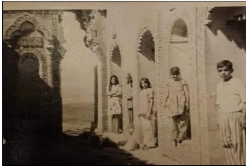
Şekil 5.22 BK-01 numaralı odanın 1989 öncesi durumu (Köy Ahalisinden)
