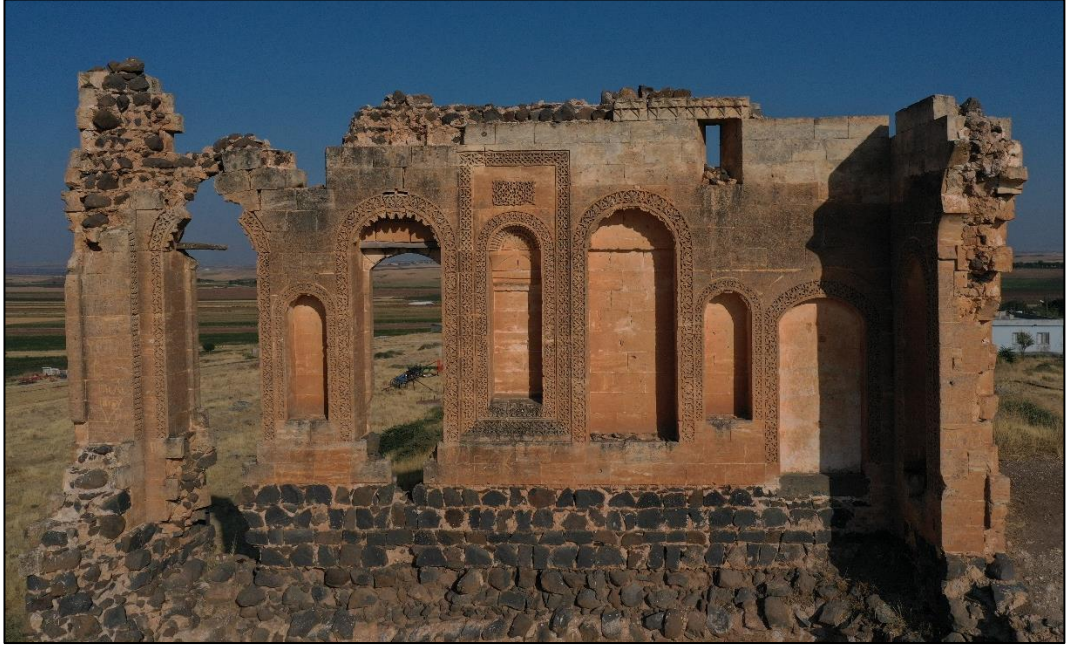
Şekil 4.25 BK-01 Nolu odanın doğu duvarı
