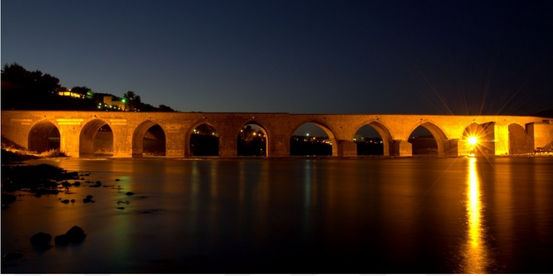
Resim 6. On Gözlu Köprü, Diyarbakır
