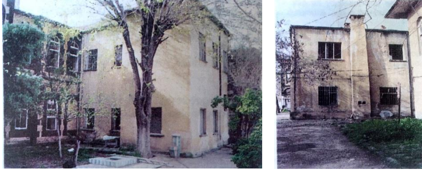
Şekil 4.30. Kolordu Binasına eklenen bölümler (Diyarbakır KVKBKM Arşivinden)
