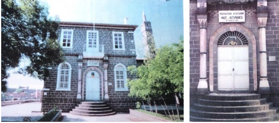
Şekil 4.26. Diyarbakır İçkale Atatürk Komutanlık Binası Güney Giriş Cephesi (Diyarbakır KVKBKM Arşivinden)
