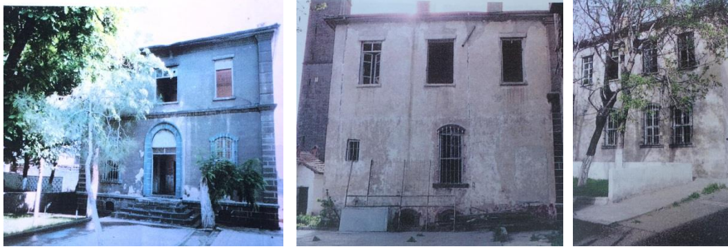
Şekil 4.28. Diyarbakır İçkale Cephanelik Binası Kuzey Giriş Cephesi, Doğu Cephesi ve Batı Cephesinden fotoğraf (Diyarbakır KVKBKM Arşivinden)
