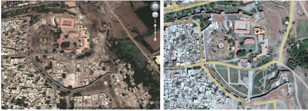
Şekil 4.36. İçkale gecekondu yapıları restorasyon öncesi ve sonrası durum
