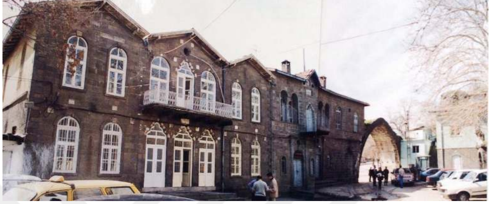
Şekil 4.25. Diyarbakır İçkale Karakol Binası Güney cephesi (Diyarbakır KVKBKM Arşivinden )
