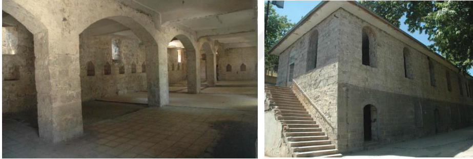
Şekil 4.24..Jandarma İstihbarat Binası İstinada çıkan Merdiven (Soyukaya, 2012)
