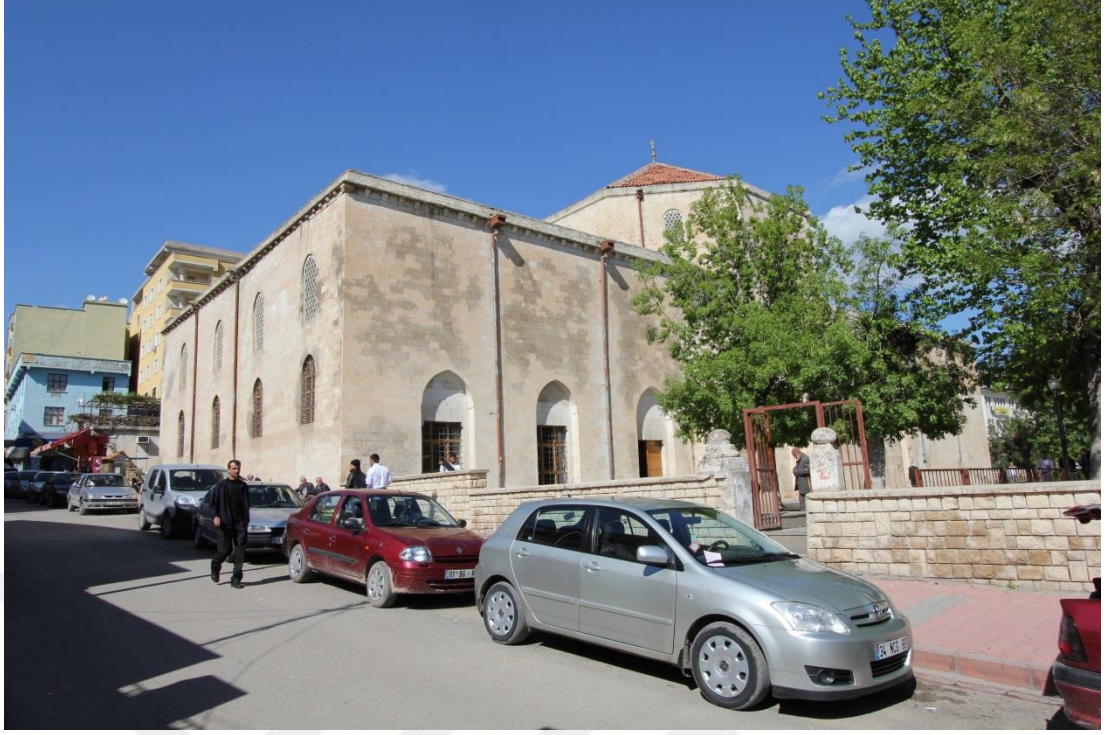
Fotoğraf: 59- Silvan Ulu Camii'nin Güneybatı Cephesi.
