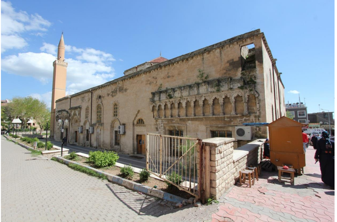
Fotoğraf: 62- Silvan Ulu Camii'nin Kuzey Cephesi.
