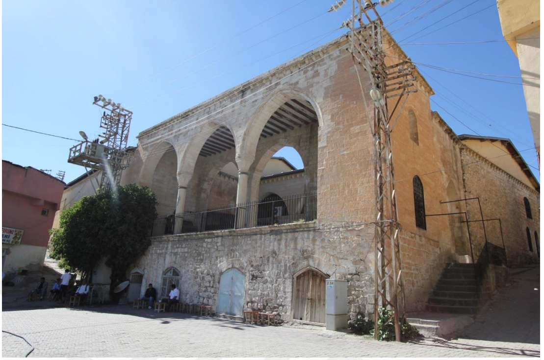
Fotoğraf: 31- Hani Ulu Camii'nin Güneydoğu Cephesi.
