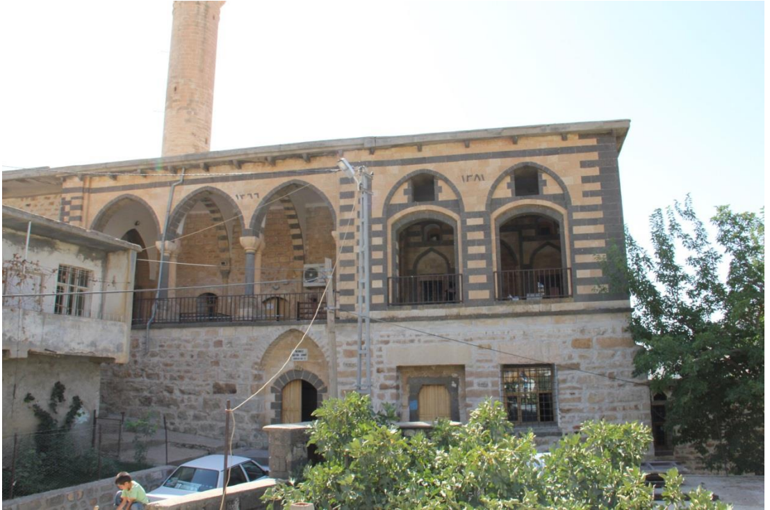
Fotoğraf: 44- Hazro Ulu Camii'nin Kuzey Cephesi.
