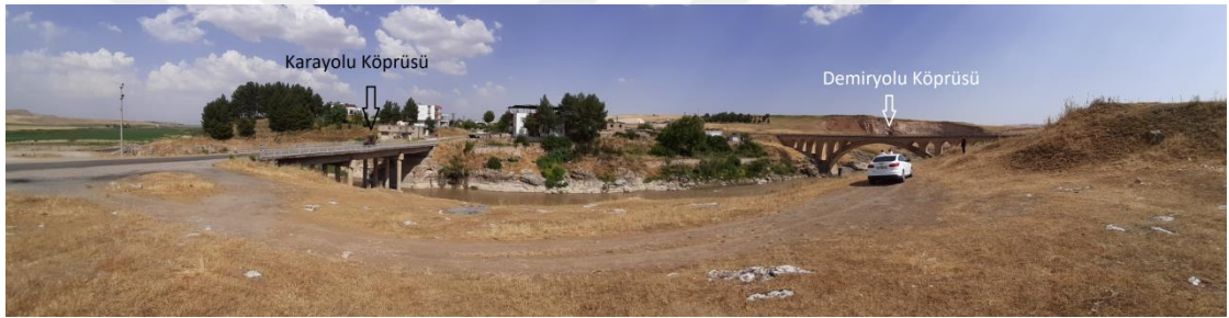
Fotoğraf 45: İkiköprü Beldesine İsim Veren Karayolu ve Demiryolu Köprüsü
