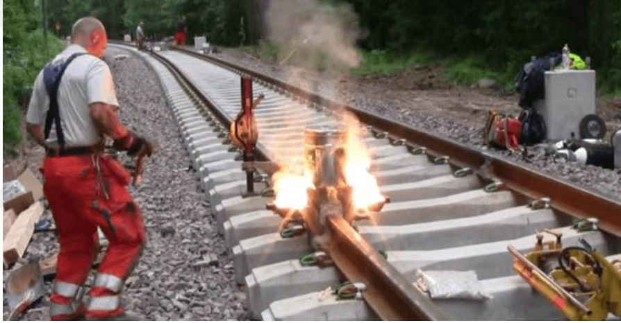
Fotoğraf 10: Termik Kaynak Yöntemi İle Rayların Birleştirilmesi (URL 3).
