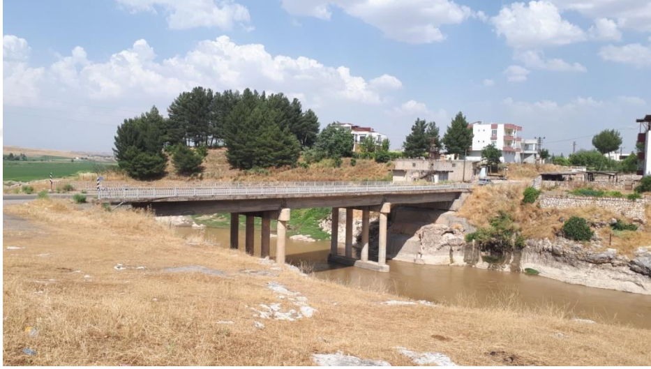
Fotoğraf 47: Garzan Köprüsü (Yıkılan tarihi karayolu köprüsü yerine yapılan yeni karayolu köprüsü) (Bozkurt Yıldız, 2019)
