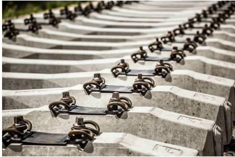
Fotoğraf 8: Beton Travers Ve Bağlantı Elemanları (URL 3)
