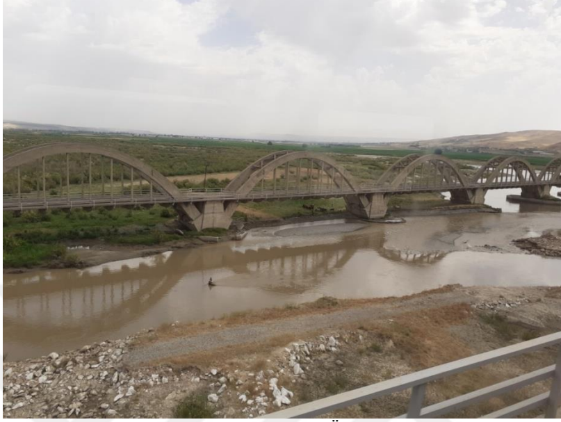
Fotoğraf 52: Sinanköy Yakınında, Batman Çayı Üzerindeki Tarihi Demiryolu Köprüsü (Bozkurt Yıldız, 2019)
