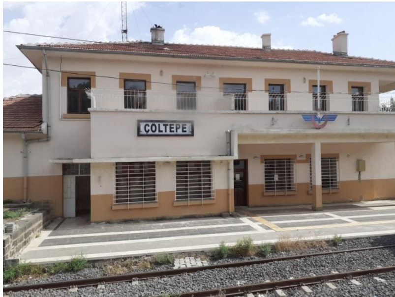
Fotoğraf 55: Çöltepe İstasyonu-Gar Binası (Bozkurt Yıldız, 2019)
