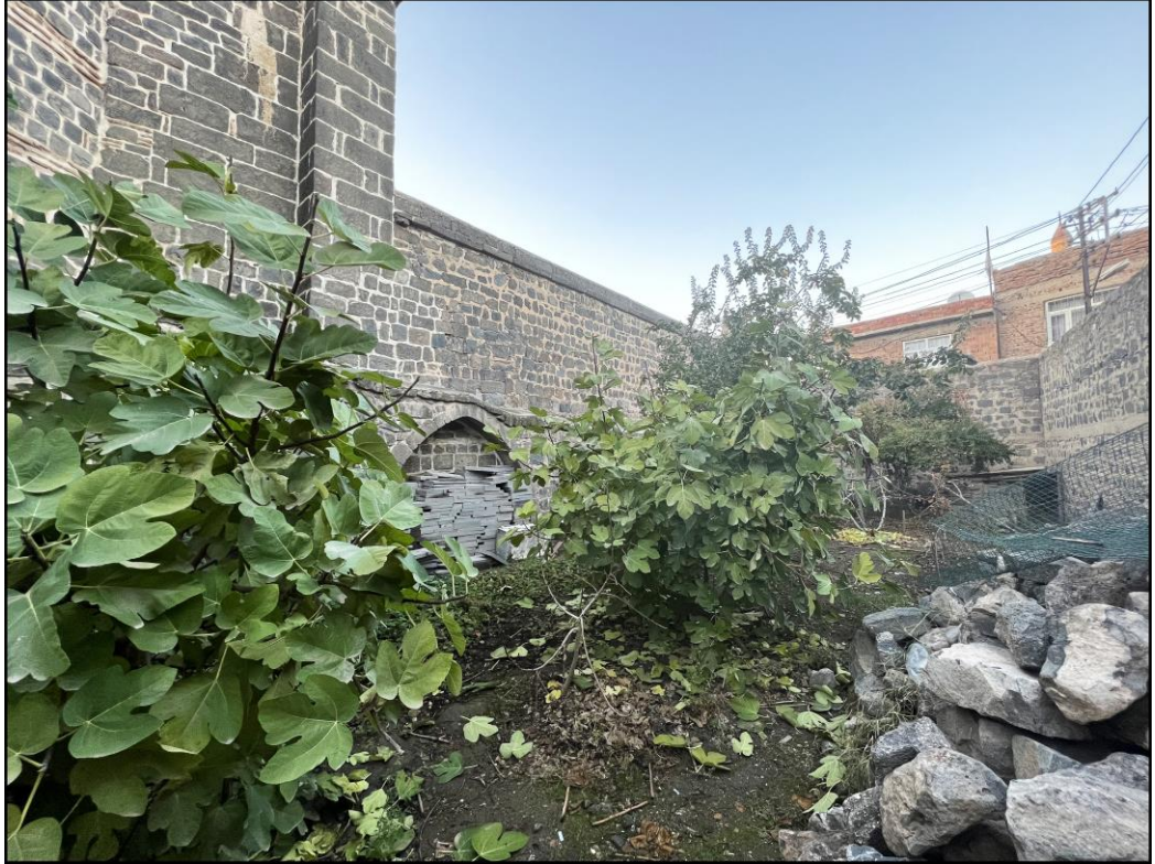
Şekil 3.43 Kilisenin doğu cephesi
