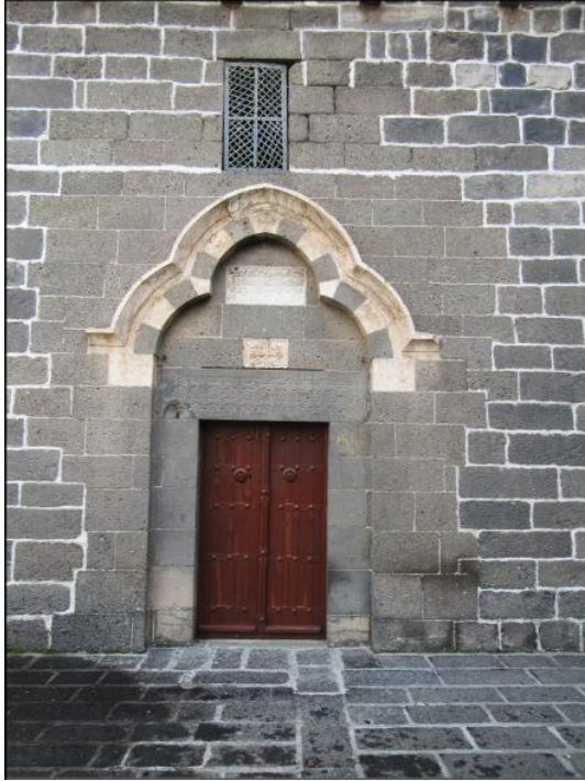
Şekil 3.31 Mor Yakup Kilisesi bölümü 1. avludan giriş kapısı
