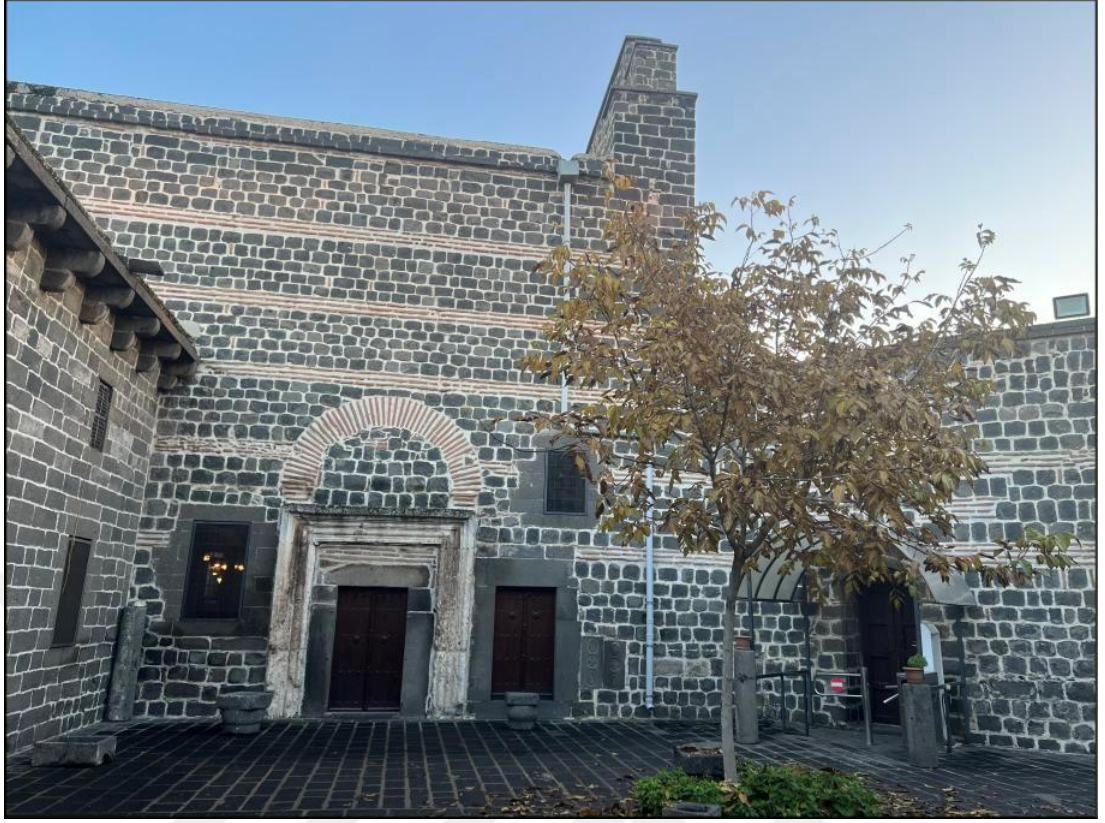
Şekil 3.40 Kilisenin kuzey cephesi
