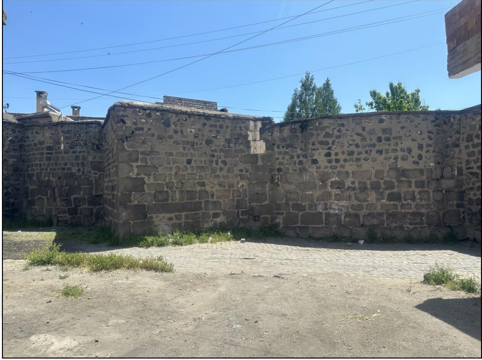
Şekil 4.15 Tetrakonch plan tipini destekleyen L tipi köşe ve ovalliklerin bulunduğu dış duvarı (detay 1)
