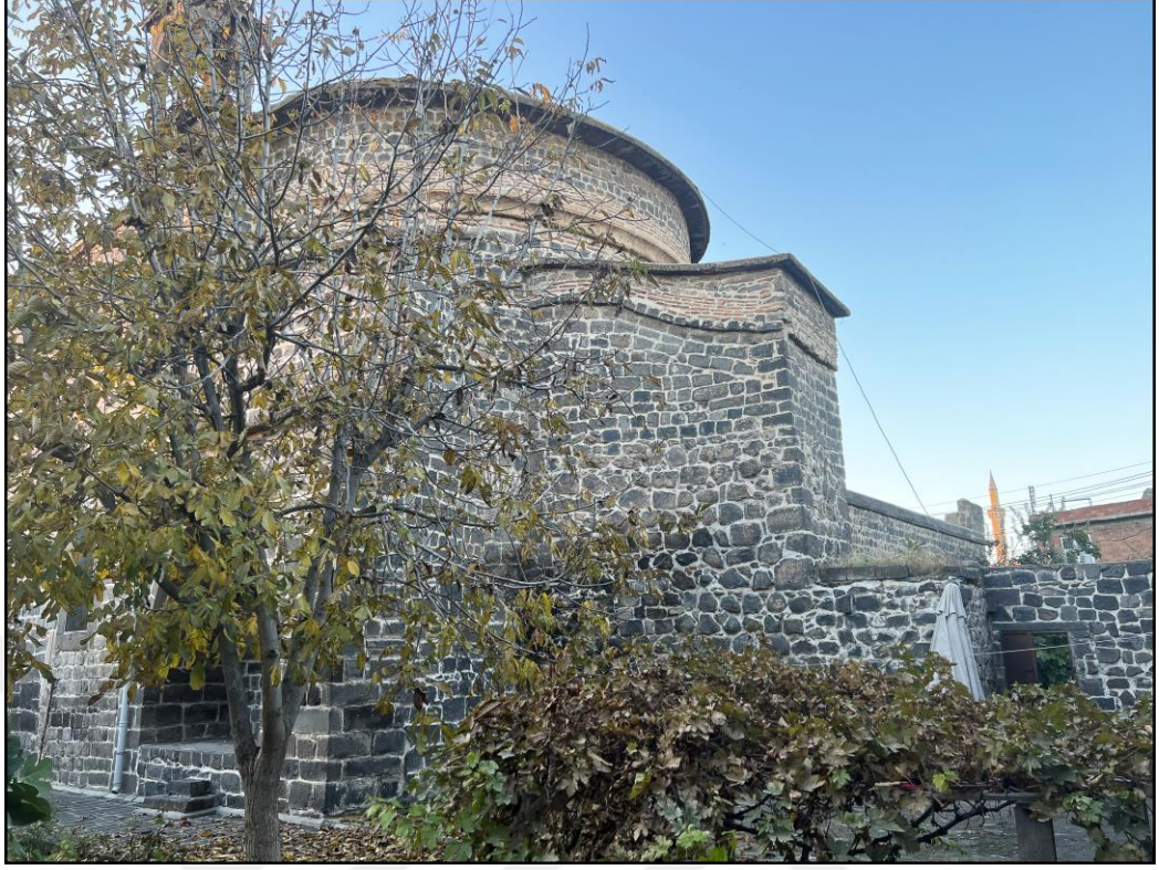
Şekil 3.42 Kilisenin doğu cephesi
