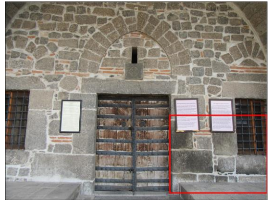
Şekil 3.51 Kilisenin narteks bölümünde oluşan kararmalar
