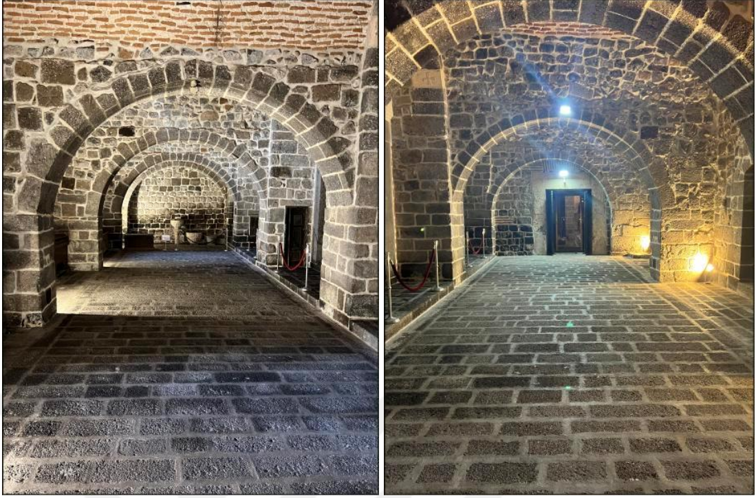
Şekil 3.30 Mor Yakup Kilisesi bölümü
