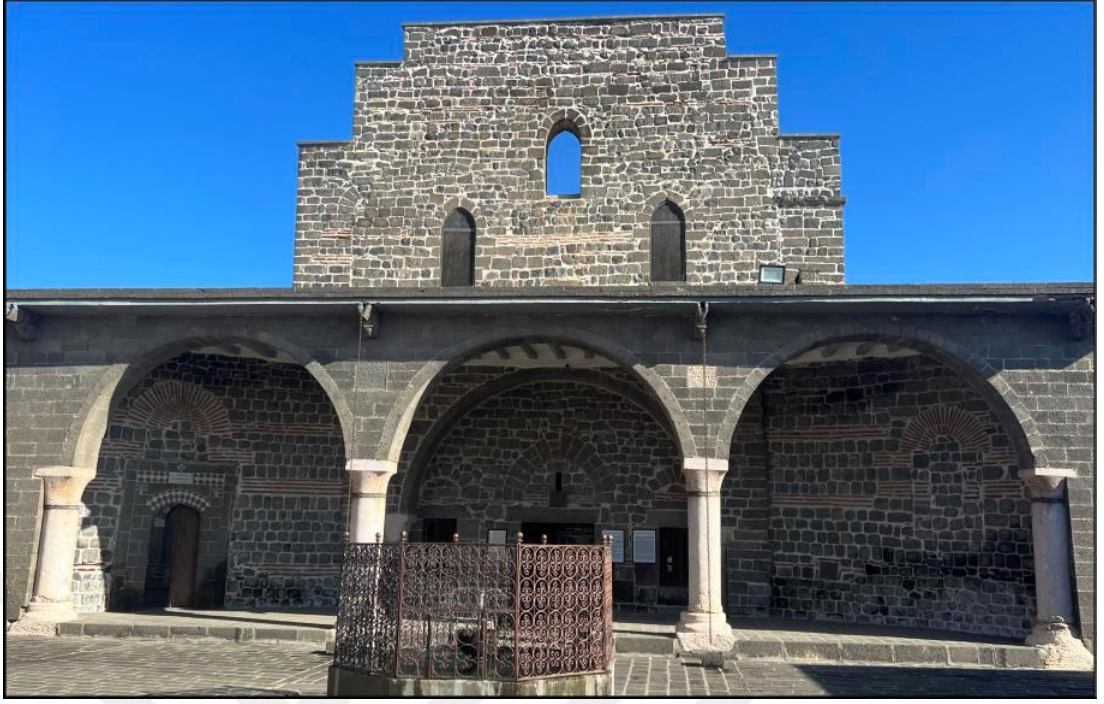
Şekil 3.35 Kilisenin batı cephesi
