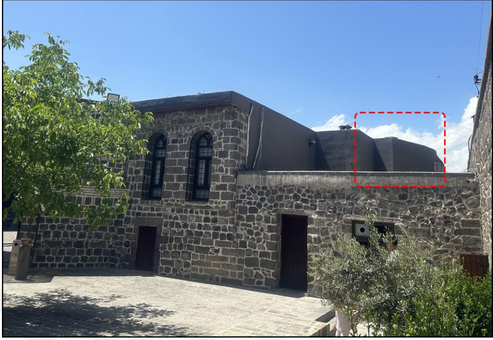
Şekil 4.17 Papaz evinin kuzeyindeki deponun damında bulunan duvar kalıntısı (detay 2)
