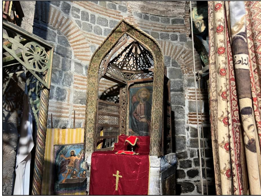
Şekil 3.57 Apsis bölümünde bulunan kapatılmış pencereler
