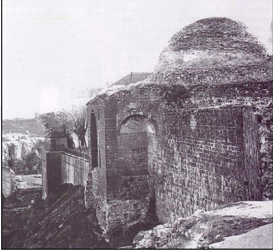
Şekil 2.10 Saint George Kilisesi'nin surların devamı olan doğu duvarı (Tuncer, 2002)
