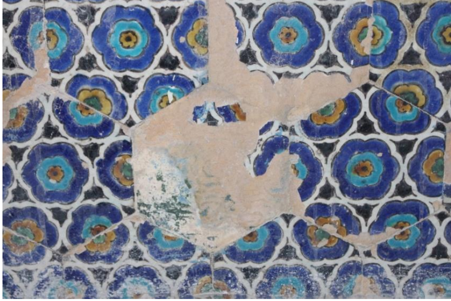
Şekil 1.22.Parlı Safa Cami kuzey cephesinden çinileri sır kaybı detayı (Yıldız, 2017).
