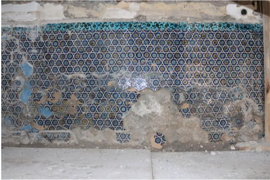
Şekil 1.14.Parlı Safa Cami güney cephesinden çinileri genel görünüm (Yıldız, 2017).
