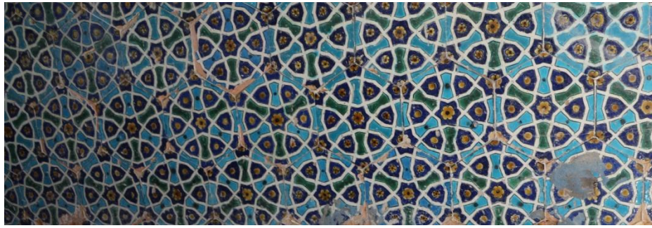
Şekil 1.19.Parlı Safa Cami batı cephesinden çinileri genel görünüm (Yıldız, 2017).
