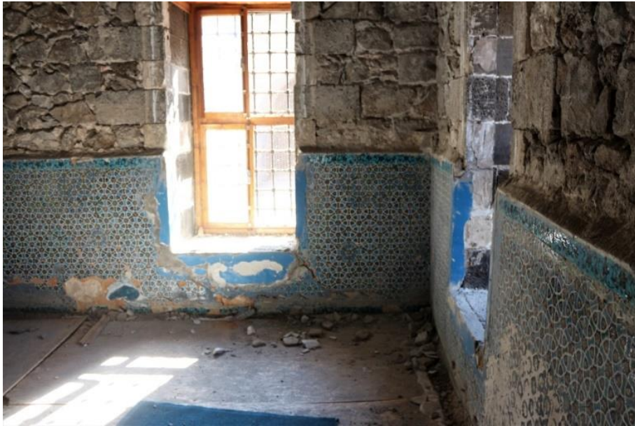
Şekil 1.12. Parlı Safa Cami güney cephesinden çinileri genel görünüm (Yıldız, 2017).
