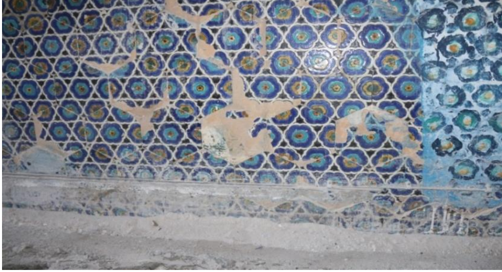
Şekil 1.21.Parlı Safa Cami kuzey cephesinden çinilerinde gözlemlenen sır kaybı (Yıldız, 2017).
