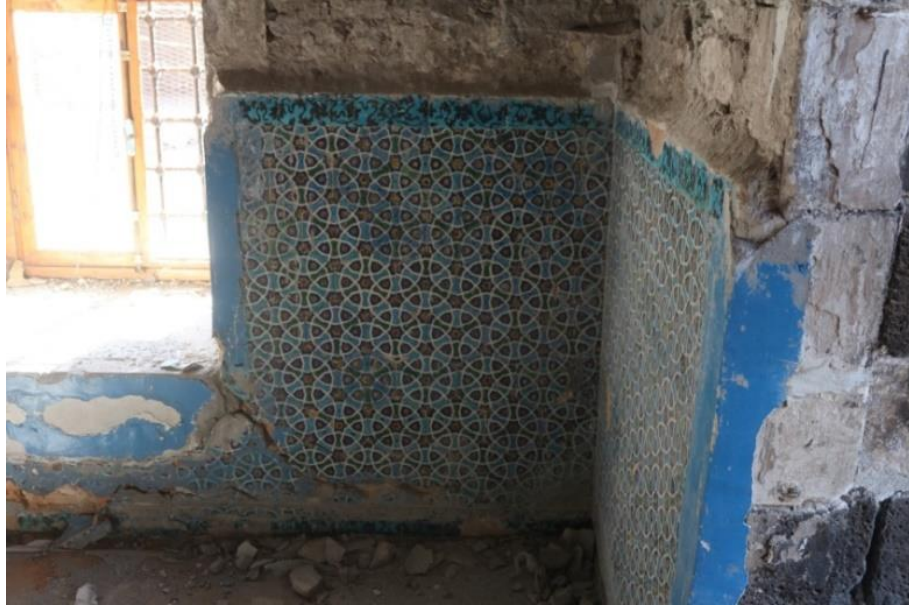
Şekil 1.28.Parlı Safa Cami güney cephesinden profil görünümü (Yıldız, 2017).
