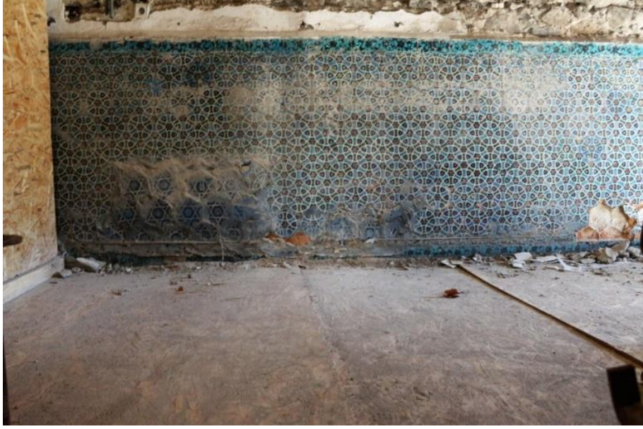
Şekil 1.13.Parlı Safa Cami güney cephesinden çinileri genel görünüm (Yıldız, 2017).
