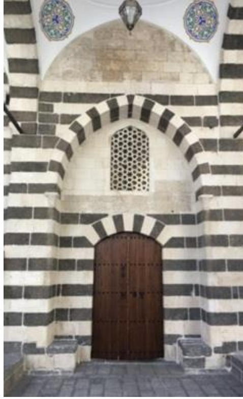
Şekil 1.3. Cami giriş kapısı üzerindeki onarım kitabesi (Yıldız, 2017*).
