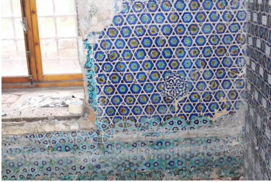
Şekil 1.18.Parlı Safa Cami batı cephesinden çinileri genel görünüm (Yıldız, 2017).
