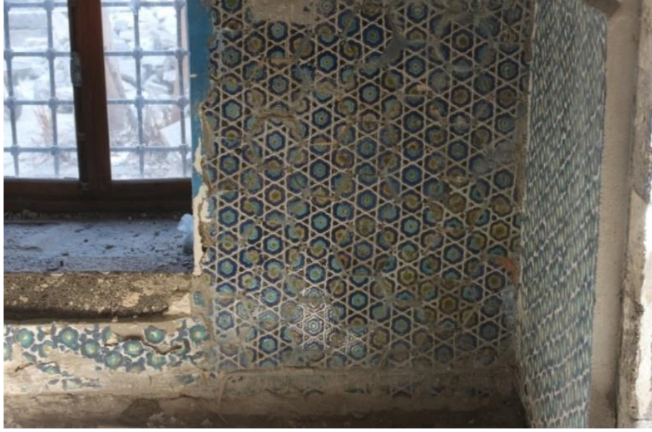
Şekil 1.30.Parlı Safa Cami doğu cephesinden genel görünümü (Yıldız, 2017).
