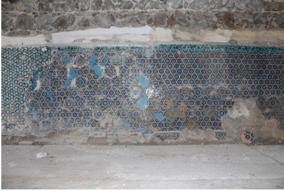
Şekil 1.15.Parlı Safa Cami güney cephesinden çinileri genel görünüm (Yıldız, 2017).
