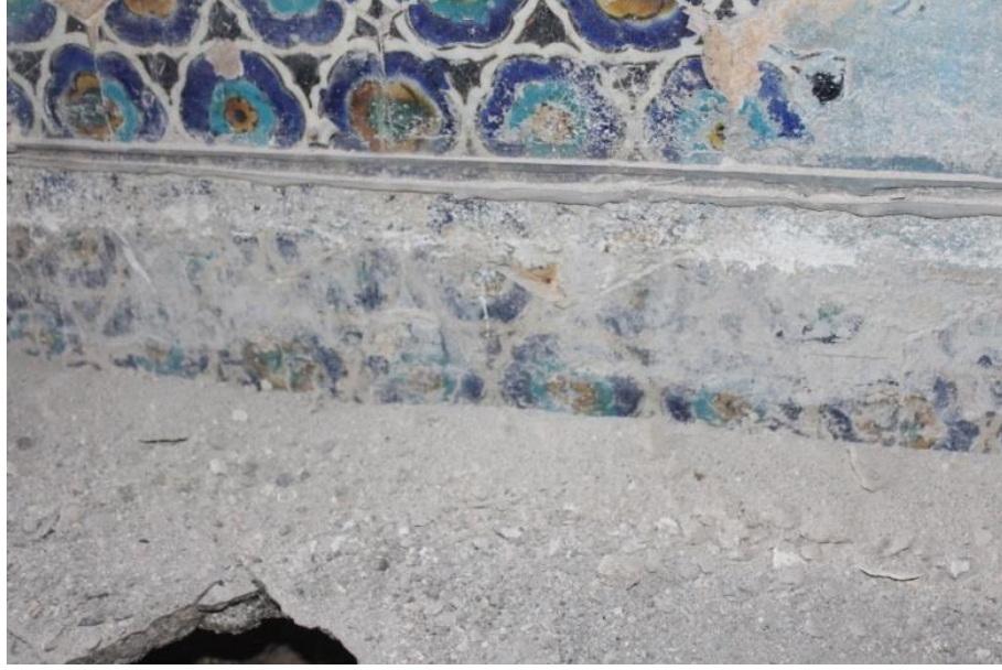
Şekil 1.24.Parlı Safa Cami kuzey cephesinden çinileri üzerindeki yabancı madde görünümü detayı (Yıldız, 2017).
