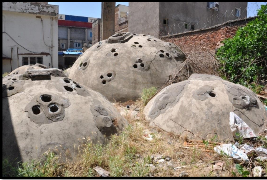
Şekil 6. 2117. Vahap Ağa Hamamı'nda Halvet ve Eyvanı Örtten Kubbeler (Nabikoğlu, 2013)
