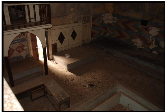
Şekil 4. 10061. Z04 Soğukluk mekânı zemin döşemesi
