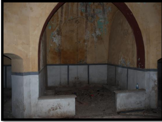
Şekil 4. 36. (Z10) Eyvan Mekânı (2013)
