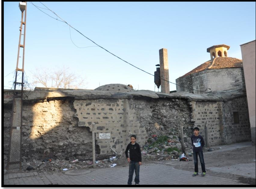
Şekil 4. 83. Batı Cephesi Sıcaklık (Z08) görünümü(2013)
