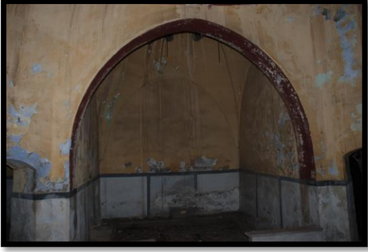
Şekil 4. 427. (Z14) Eyvan Mekânı(2013)
