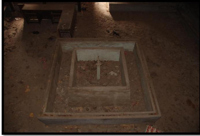
Şekil 4. 21. (Z04) Soğukluk Mekânında bulunan eklenti havuz (2013)
