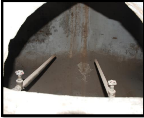
Şekil 4. 69. (Z17) Su Deposu Mekânı
