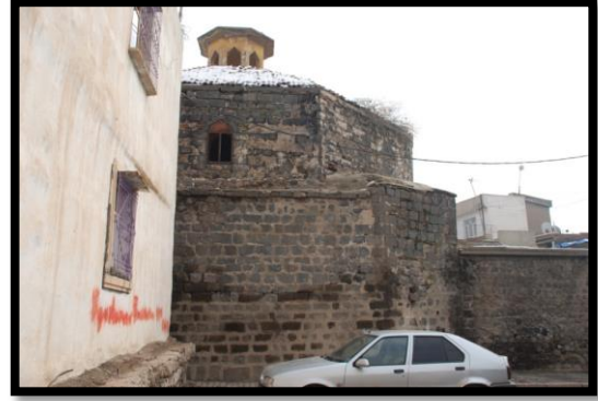
Şekil 4. 85. Batı Cephesi Soğukluk (Z04) görünümü(2013)
