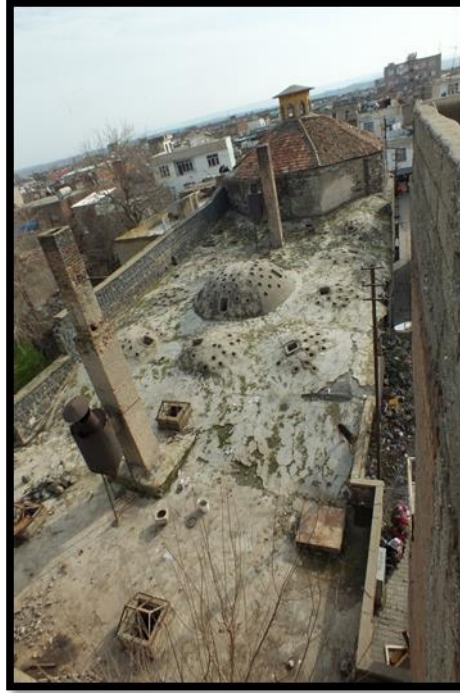
Şekil 4. 107. Üst Örtü Görünüşü (2013)
