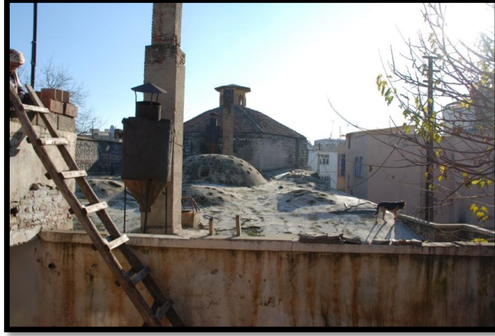
Şekil 4. 8754. Kuzey Cephesi genel görünüm(2013)
