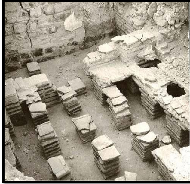
Şekil 5. 3. Saray hamamına ait hypocaust kalıntısı (Sözen, 1971)
