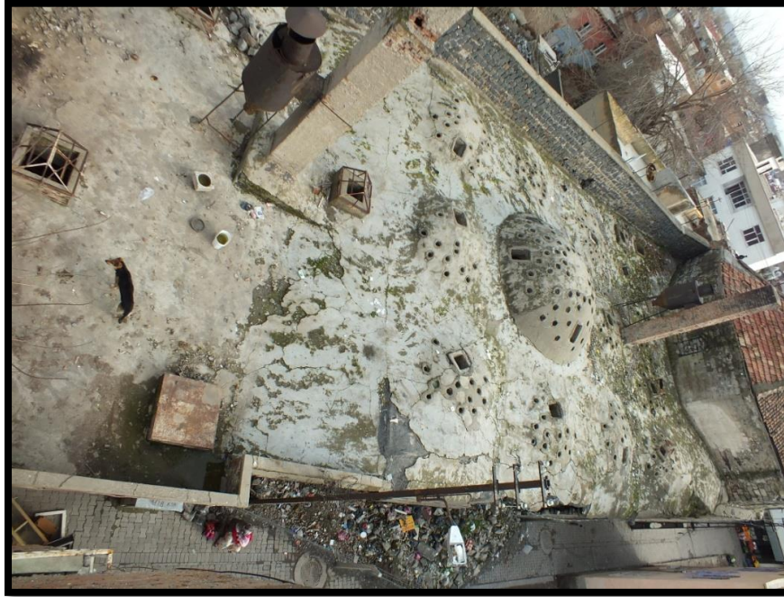
Şekil 4. 10562. Üst Örtü Görünüşü(2013)
