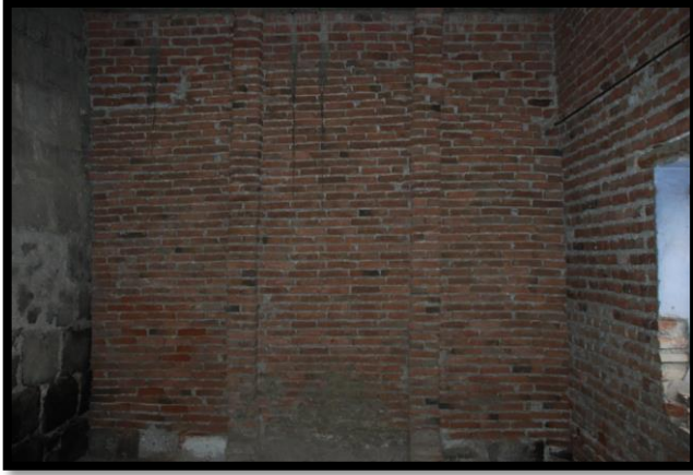
Şekil 4. 57. Z02 Oda Tuğla Duvar Görünüşü(2013)
