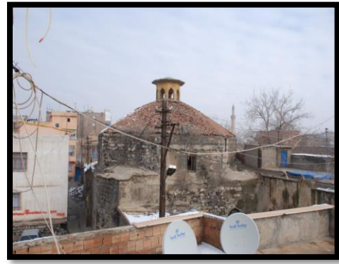
Şekil 4. 519. Yeni Kapı Sokak (Güney) cephesi
