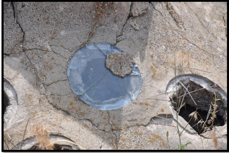
Şekil 6. 14. Yakın Dönemde yapılan ışıklıklar – Deve Hamamı (A. Nabikoğlu)
