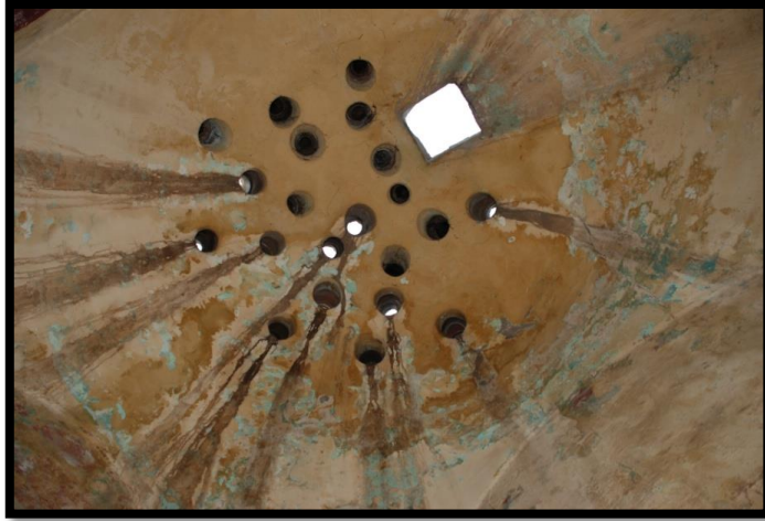
Şekil 4. 52. (Z12) Mekânına ait tavanına görünümü (2013)
