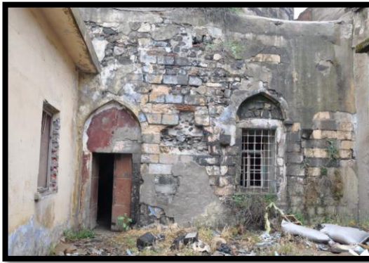
Şekil 4. 508. Avluya bakan Cephesi (2013)
