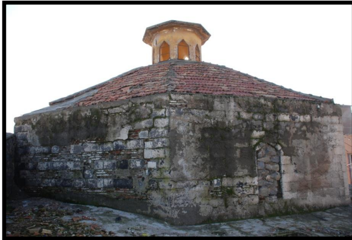
Şekil 4. 558. Kuzey Cephesi kubbe kasnağı görünümü(2013)
