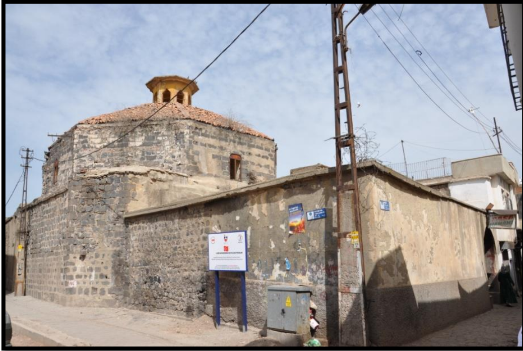
Şekil 4. 8152. Batı Cephesi Yeni Kapı Sokak genel görünümü(2013)
