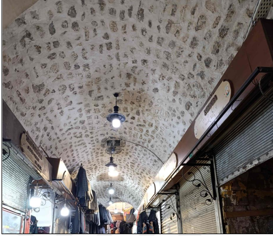
Fotoğraf 68: Şanlıurfa Ayakkabıcılar Çarşısı sonradan dâhil edilen çarşı üst örtü detayı (şahsi çekim).
