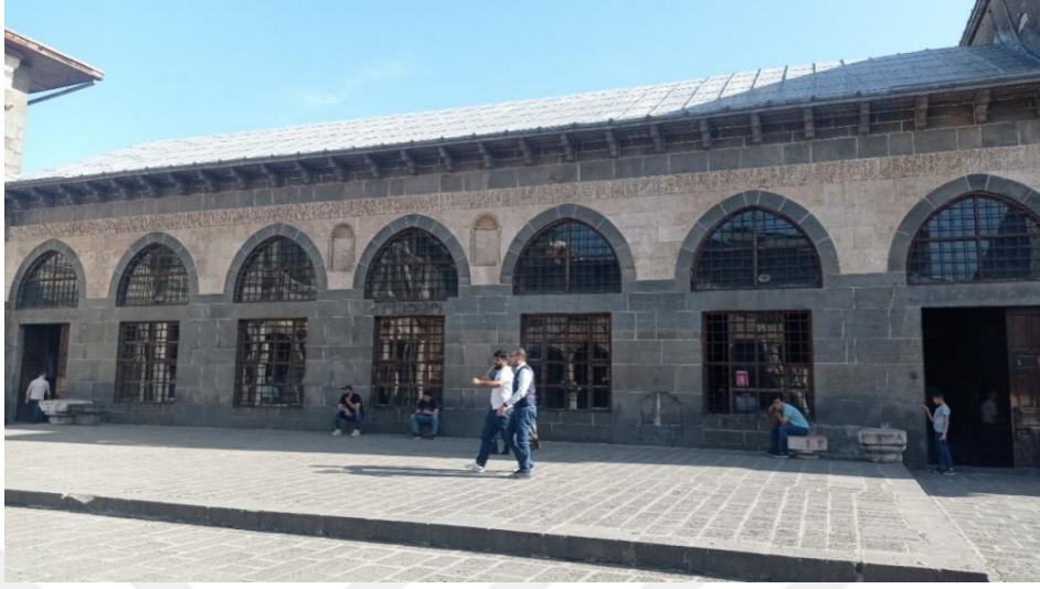
Resim 4. 52. Diyarbakir Ulu Camii Hanefiler bölümü (2024)
