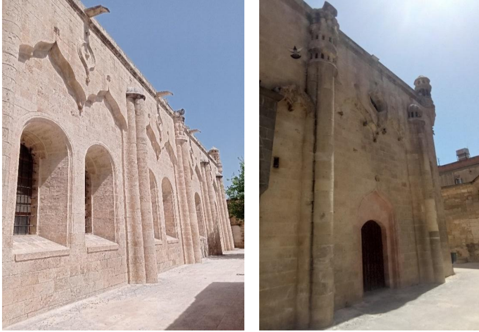
Resim 4. 96. Fırırlı Camii cephelerindeki taş işçilik (2024)
