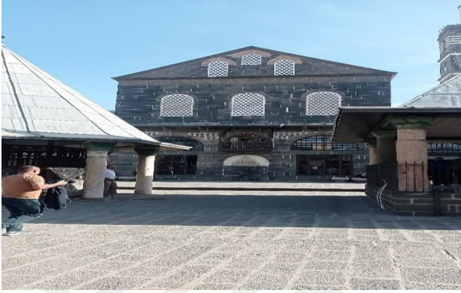
Resim 4. 35. Diyarbakır Ulu Camii güney kısmı (2024)
