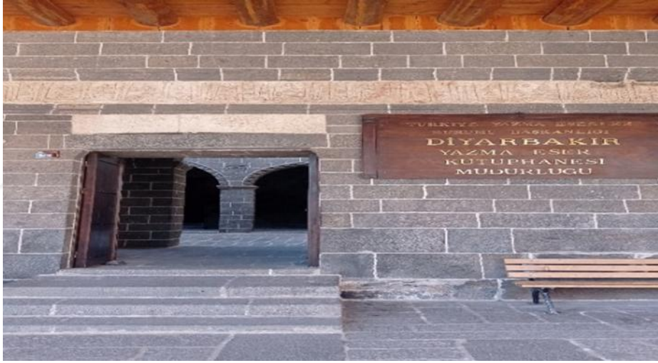
Resim 4. 56. Diyarbakir Ulu Camii Mesudiye Medresesi giriş kapısı (2024)
