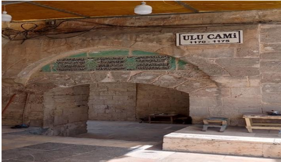
Resim 4. 77. Şanlıurfa Ulu Camii batı giriş kapısı ve üzerindeki kitabe (2024)
