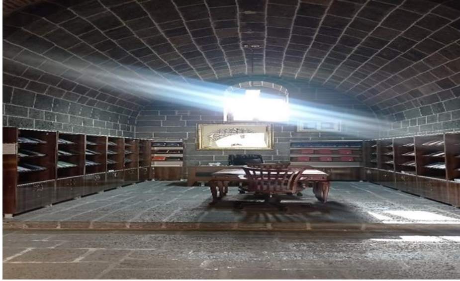
Resim 4. 58. Diyarbakır Ulu Camii Mesudiye Medresesi içi (2024)
