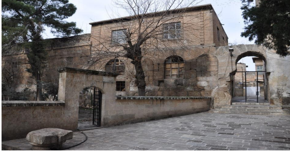
Resim 4. 78. Şanlıurfa Ulu Camii kuzey giriş kapısı (Güler, 2011)
