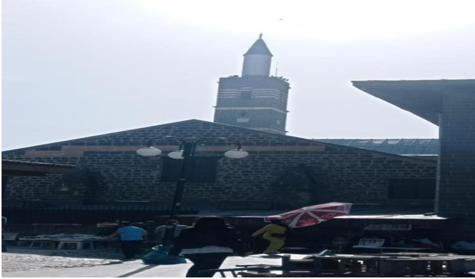
Resim 4. 43. Diyarbakır Ulu Camii minaresi (2024)
