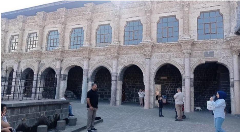
Resim 4. 42. Diyarbakır Ulu Camii batı kısmı (2024)
