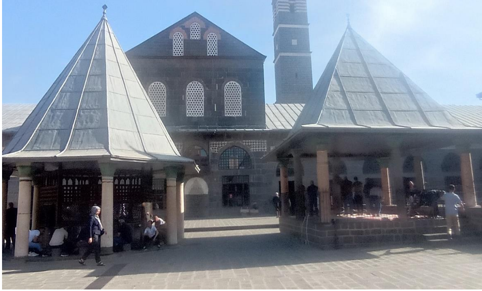
Resim 4. 51. Diyarbakır Ulu Camii namazgâhı ile şadırvanı (2024)
