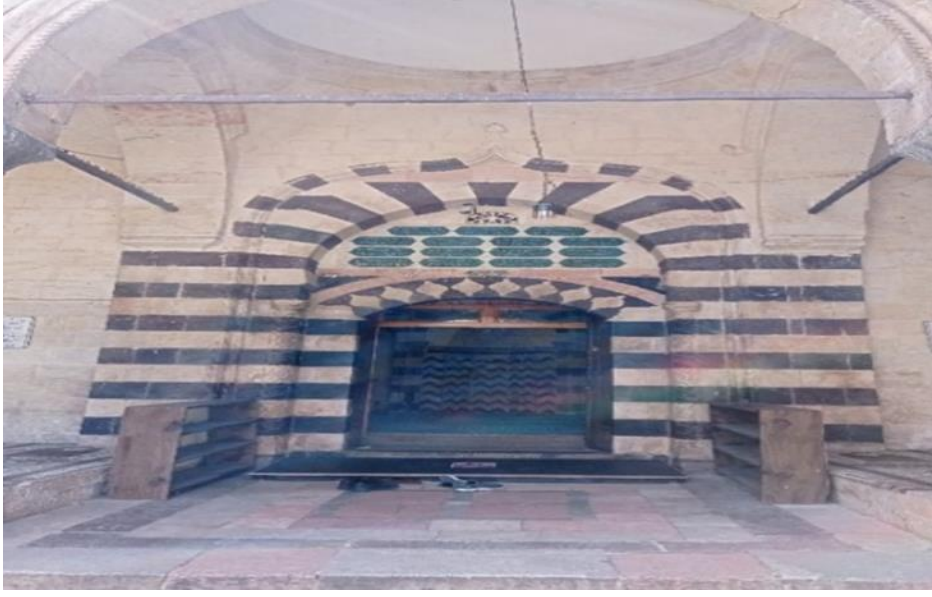
Resim 135: Rızvaniye Camii giriş kapısı (2024)
