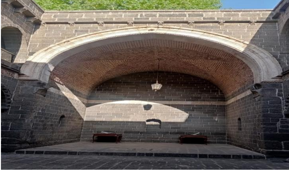
Resim 4. 62. Diyarbakır Ulu Camii Mesudiye Medresesi eyvan kısmı (2024)
