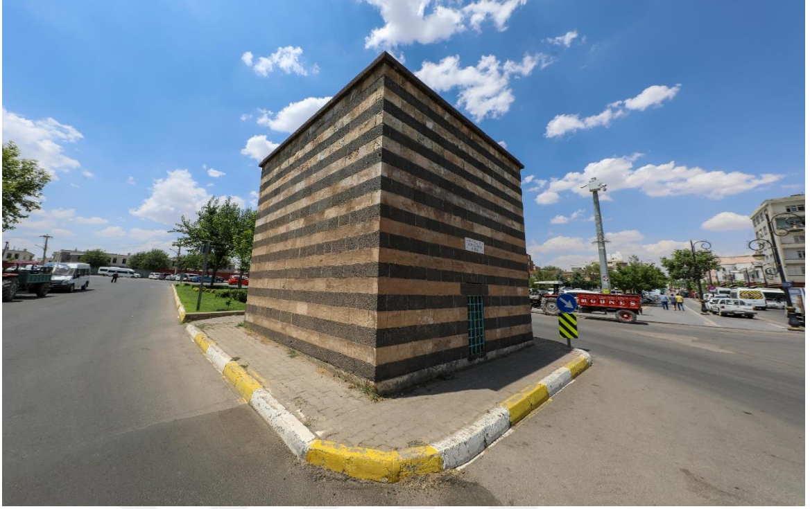
Foto 31. Sultan Şuca Türbesi. 746
