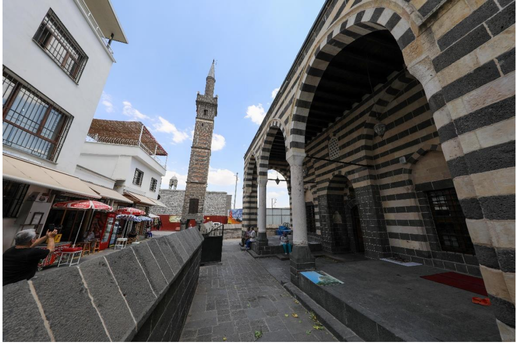
Foto 28. Şeyh Mutahhar (Matar) Camii ve Dört Ayaklı Minare. 743
