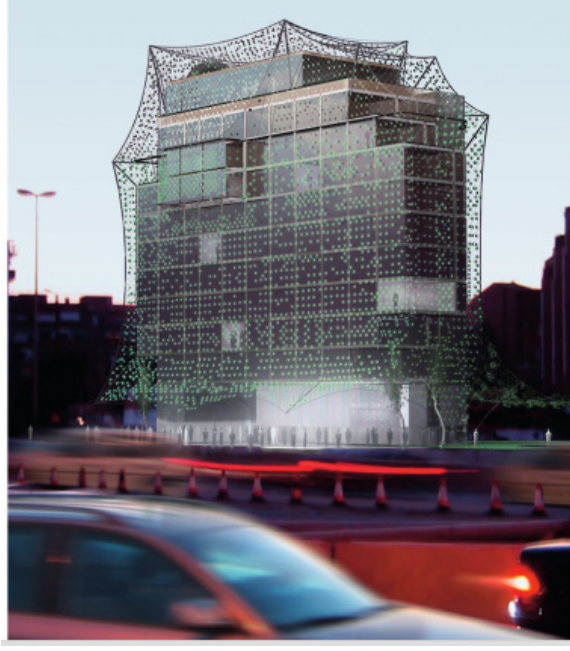
Şekil 3.28: Kinetik voksel cephe sistemi (Ritter,2007).
