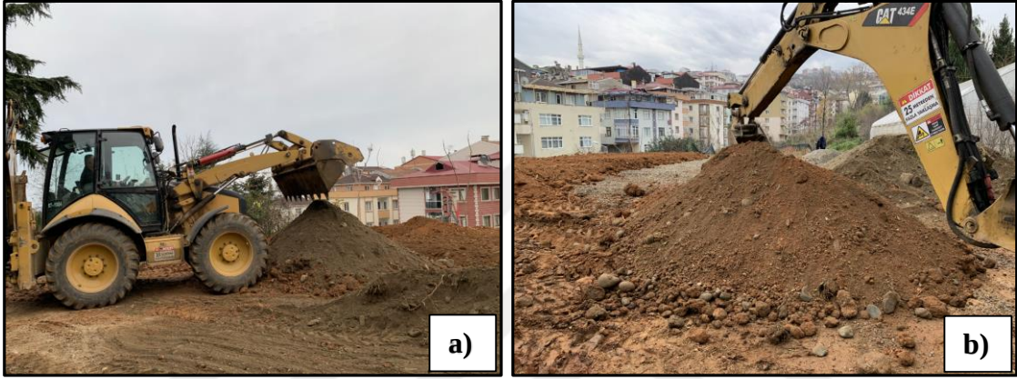
Şekil 48. a) Besi ortamı materyallerinin hacimsel oranlarına göre taşınması, b) besi ortamı karışımlarının homojen olacak şekilde kepçe yardımıyla hazırlanması
