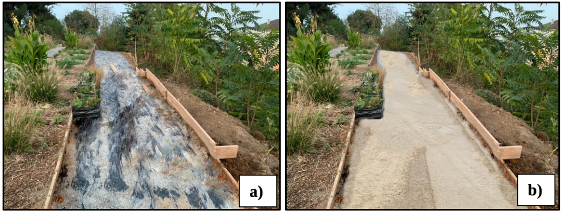
Şekil 63. a) Çakıl altına yabancı ot mücadelesi için serilen taban örtüsü, b) yollara serilen ince taneli çakıl genel görünümü
