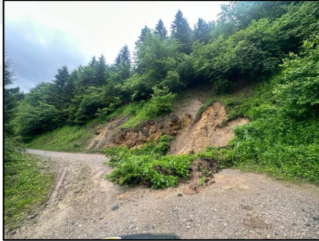
Şekil 209. Arazi çalışmaları sırasında yağın yağmurlardan sonra oluşan toprak kayması
