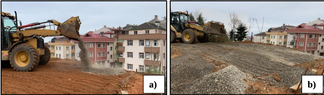
Şekil 46. a) Drenaj çakılının kepçe ile taşınması, b) drenaj çakılı kepçe ile tesviye işlemi
