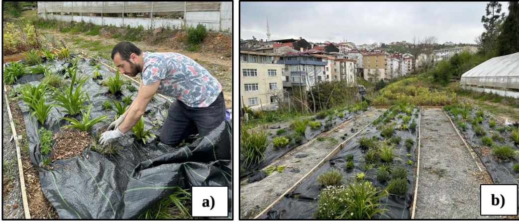
Şekil 66. a) Taban örtüsü jütün her bitki için boyutlarına göre kesilerek jütten çıkarılması, b) jüt çekilmiş parsellerin bir görünümü.
