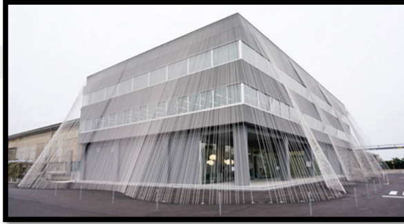
Şekil 2.7 Kompozit destekli depremde korunma (Mileberg, 2016)
