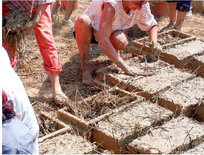
ekil 1.1. Kompozit kerpi yapımı (Anonim a, 2021)
