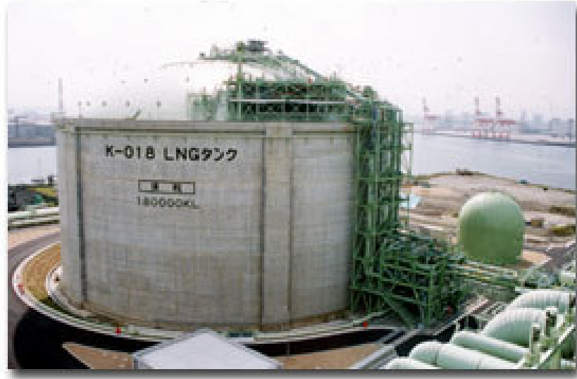
Resim 9.2. Betondan yapılan LNG depolama tankı
