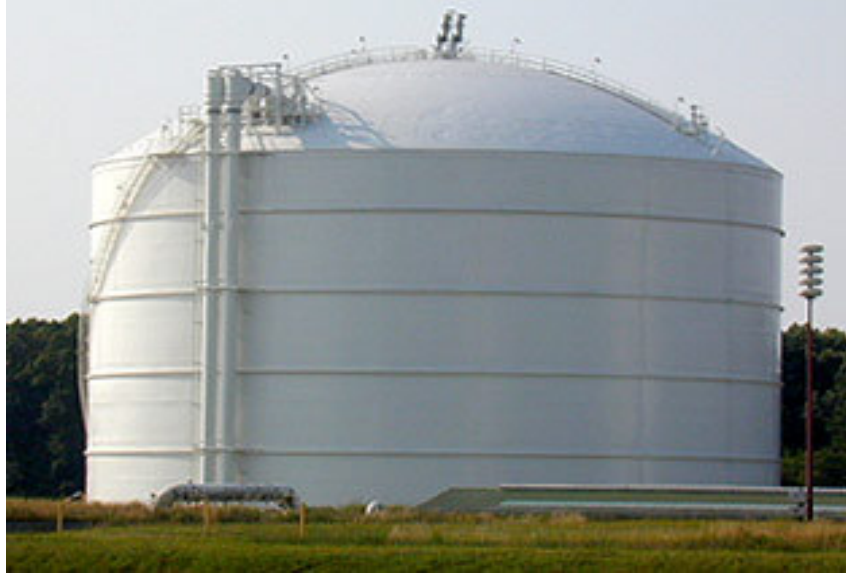
Resim 9.1. Betondan yapılan LNG depolama tankı
