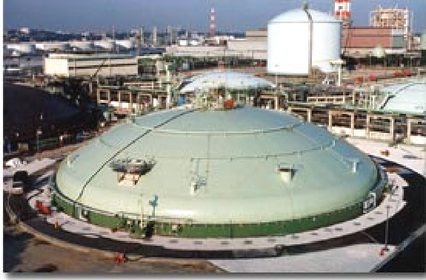
Resim 9.3. Çift duvarlı metalik konstrüksiyonlu LNG depolama tankı
