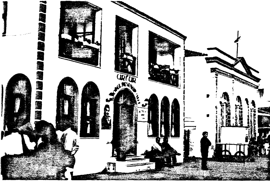
Fotoğraf:5.17 Turistik Tesise Dönüştürülen Tescilli Eski Eser Yapılar.
