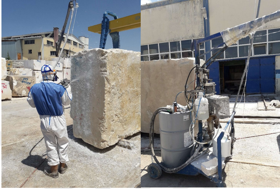
Resim 2.1 Blok saęlamlaştırma işlemleri.
