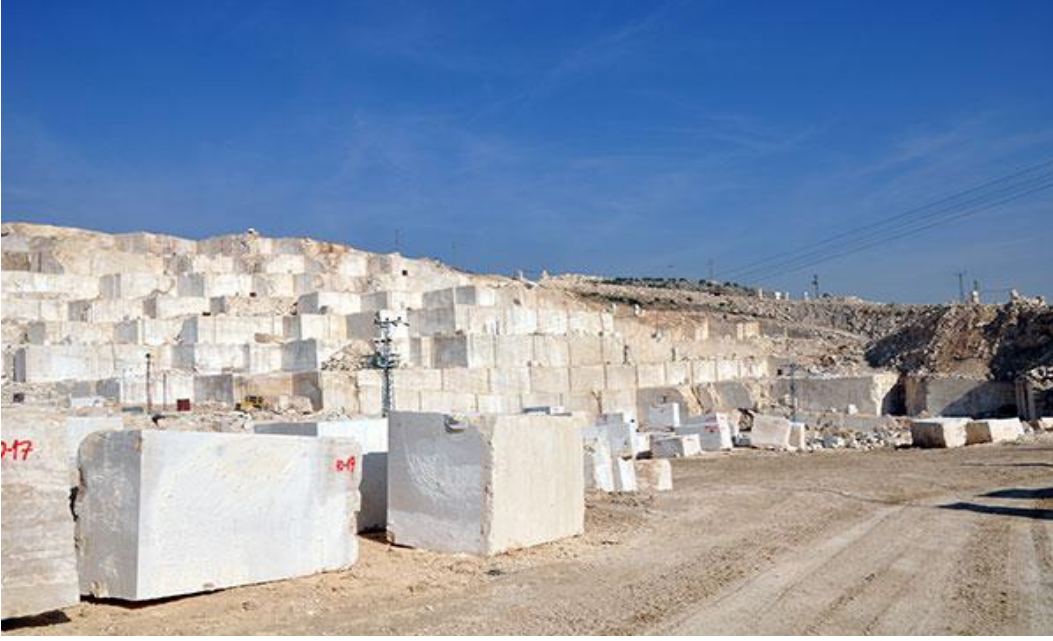
Şekil 10. Mermer ocağında kademe yöntemi uygulanması
