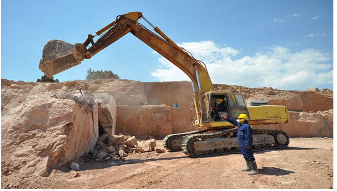
Şekil 4. Alimoğlu marble ova tipi açık rampasız doğal taş ocakları
