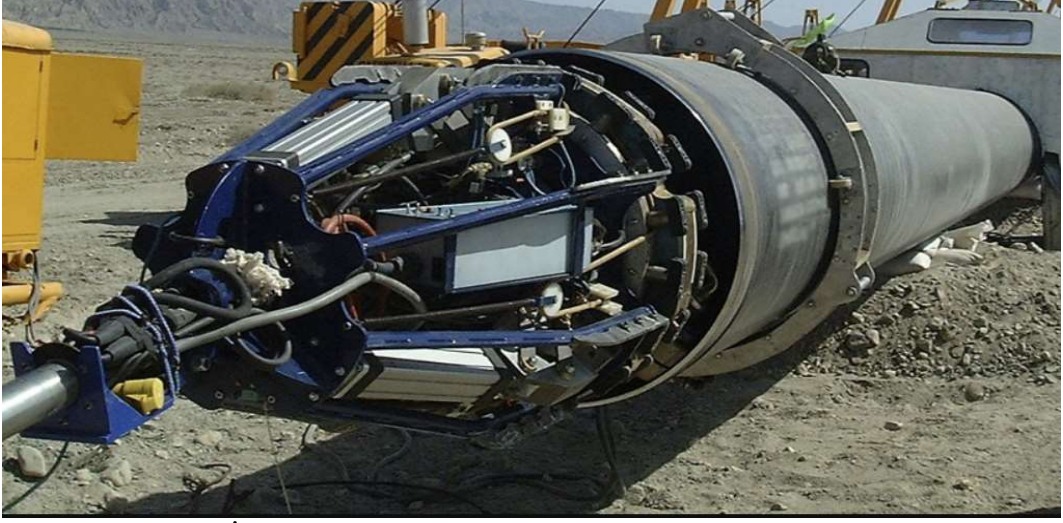
Fotoğraf 4.2. İç Kelepçe ile Boru Ağızlama. (The Validation Center, 2020)
