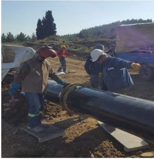
Fotoğraf 4.3. Dış Kelepçe ile Boru Ağızlama.
