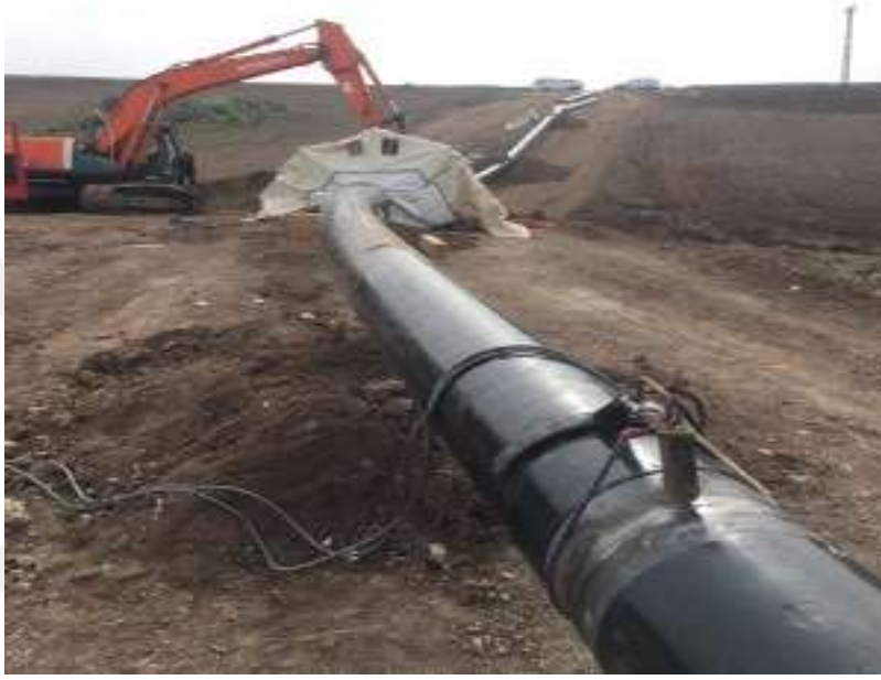
Fotoğraf 3.2. Boru Hatlarında Şase Kullanımı.
