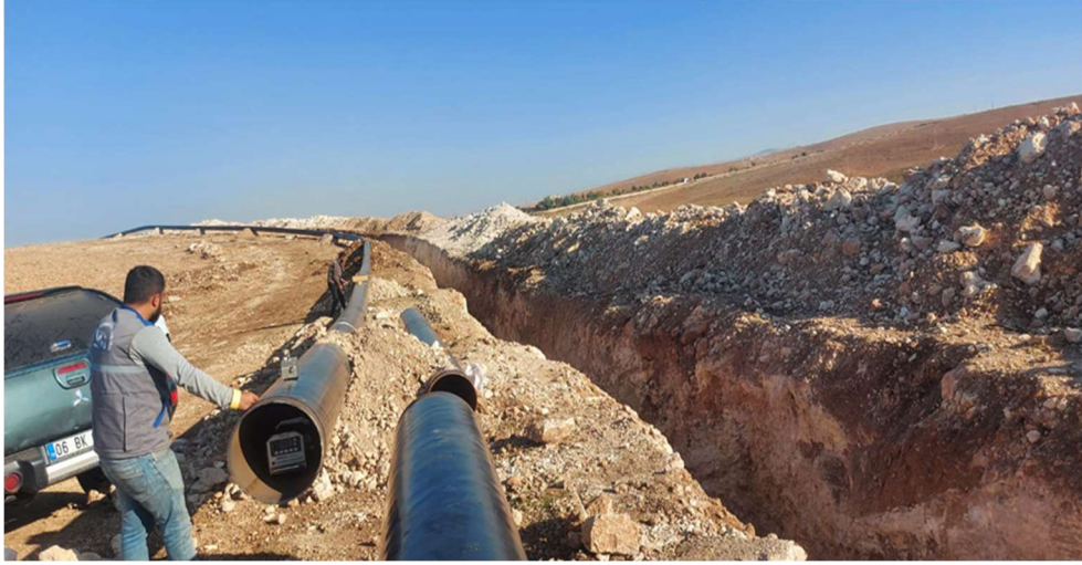
Fotoğraf 6.5. X-Ray Cihazı Boru İçerisine Yerleştirilirken.
