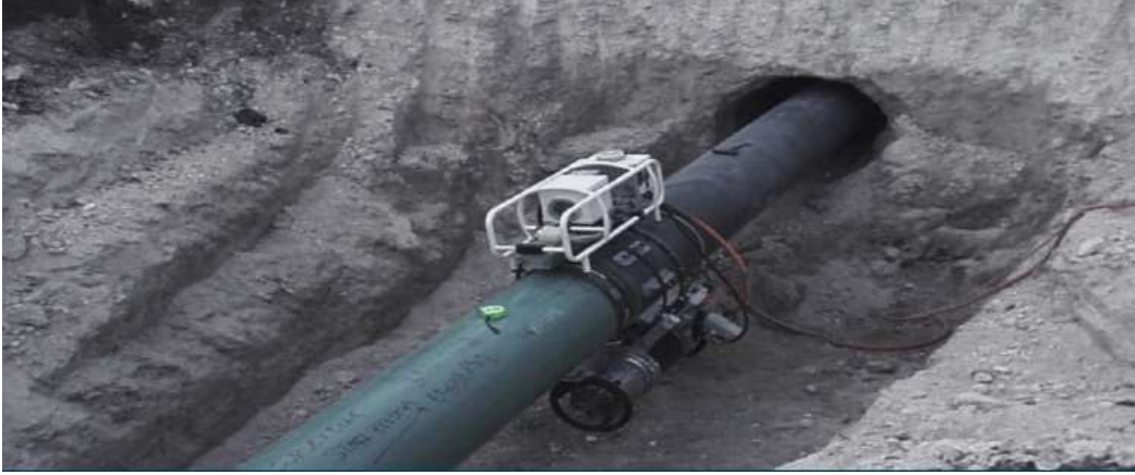
Fotoğraf 6.3. DR Tie-in Bağlantı Uygulaması.
