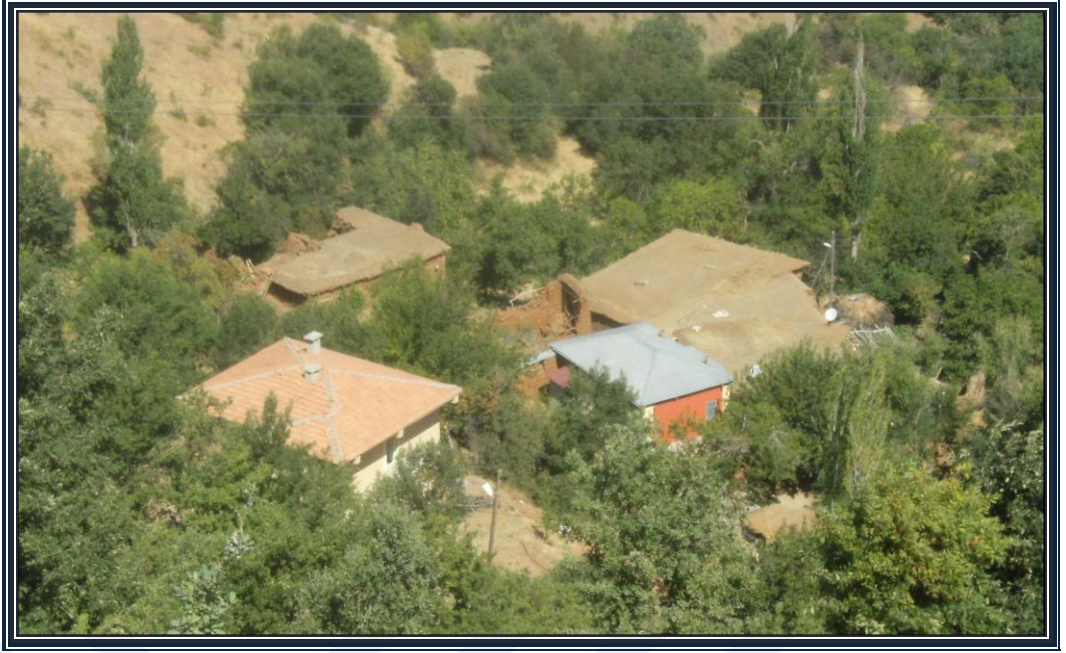
Foto 23: Depremden Zarar Görmüş Konutların Yanına İnşa Edilen Sac Örtülü ve Kiremit Örtülü Kıрма Çatı Sistemine Sahip Betonarme-Tuğla Meskenler (Yalınca Köyü)
