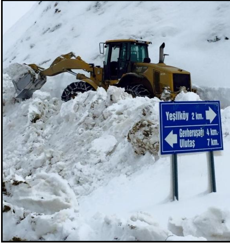
Foto 2: Büyükşehir Belediyesi ekipleri tarafından kardan dolayı kapanan köy yollarını açma çalışmaları
