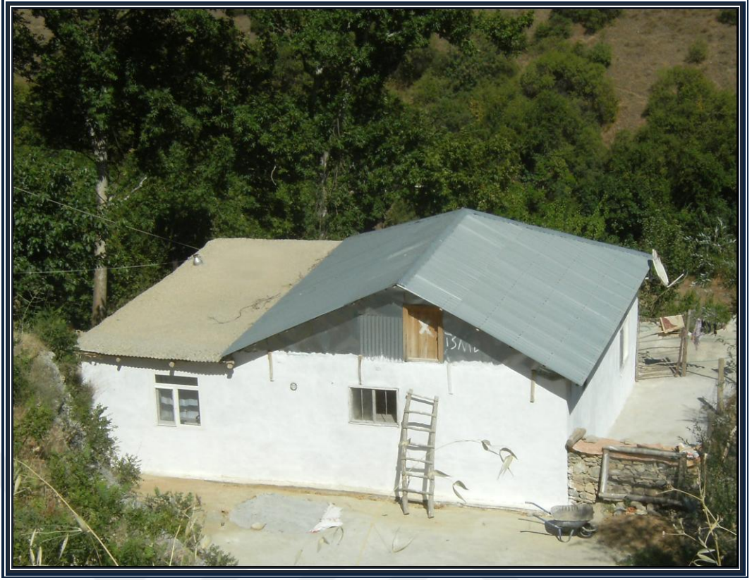
Foto 21: Çatısının bir bölümü düz dam olarak muhafaza edilmiş, diğer tarafı beşik çatılı bir mesken (Konurtay Köyü)
